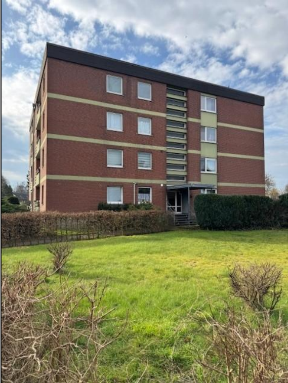
Außenansicht Zugangsbereich /Nordseite
