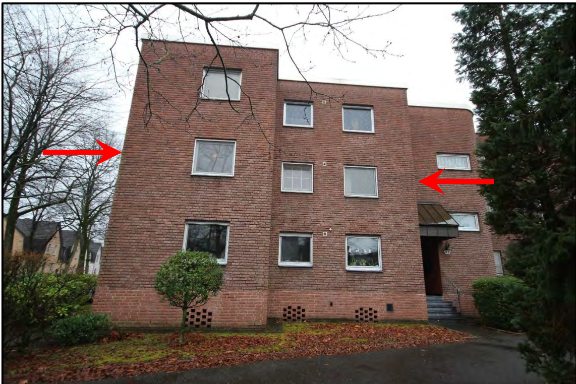
Bild 4: Ansicht von Nordosten
