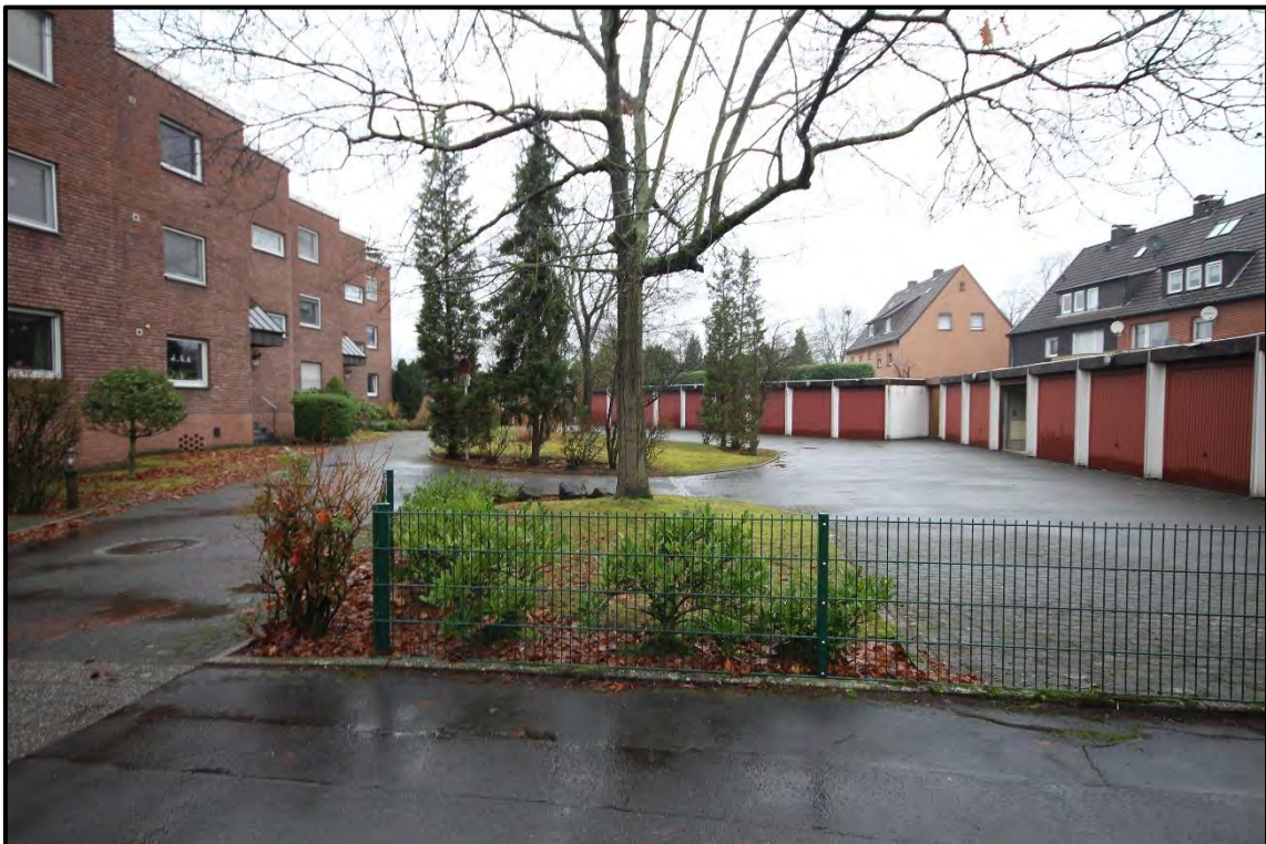
Bild 10: Blick in den Garagenhof
