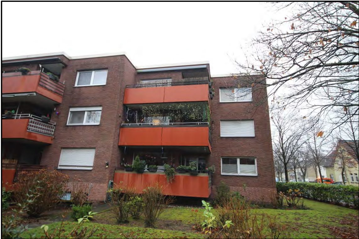
Bild 9: Ansicht von Südwesten
