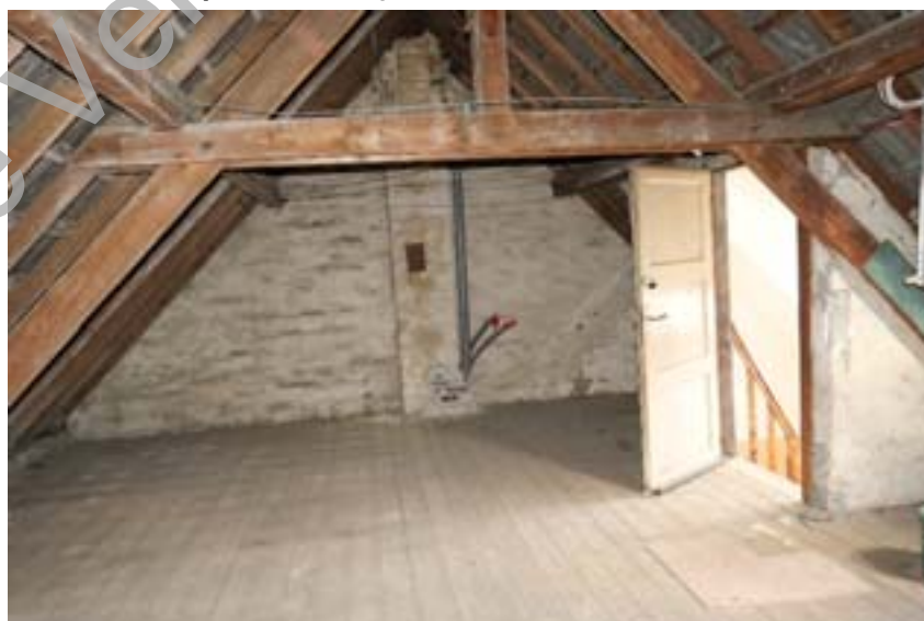
Speicher Dachgeschoss (Wohnhaus LP Nr. 1)
