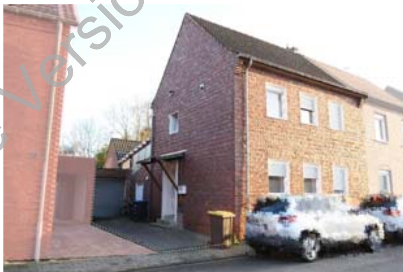
Straßenansicht (Garage LP Nr. 3, Wohnhaus LP Nr. 1)
