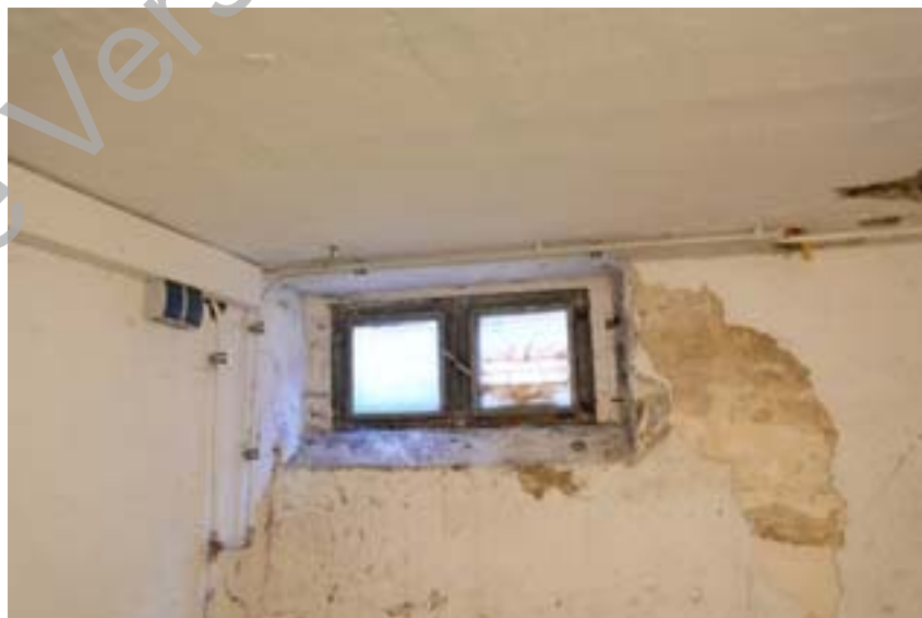
Kellerraum (Wohnhaus LP Nr. 1)
