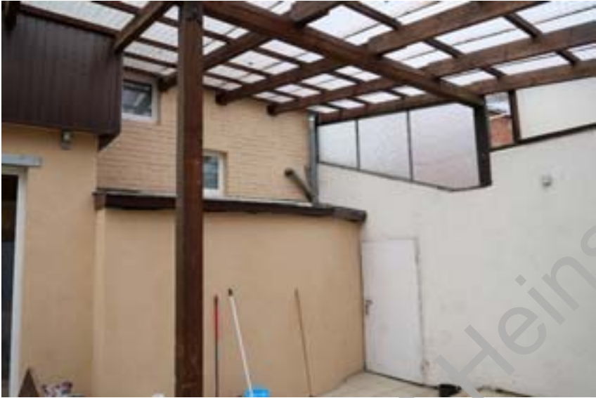
Hofüberdachung (LP Nr. 2)
