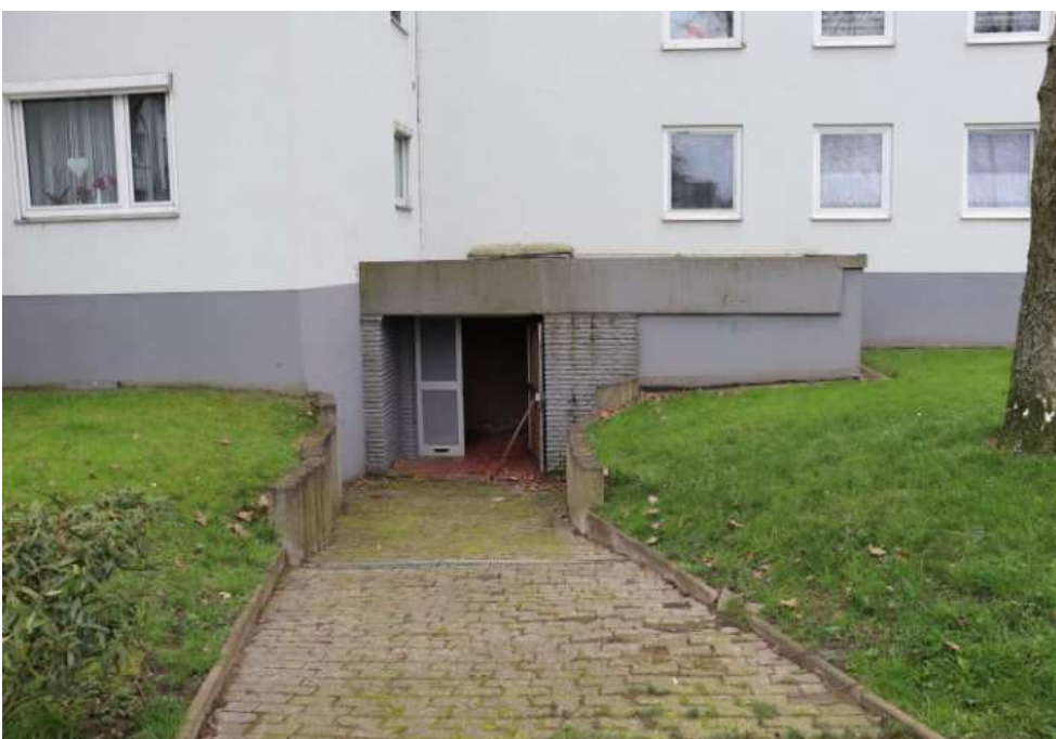
Bild 10 Worderfeld 10 -Eingangsbereich zum Teileigentum Nr. 73 (Schwimmbad, Sauna)-
