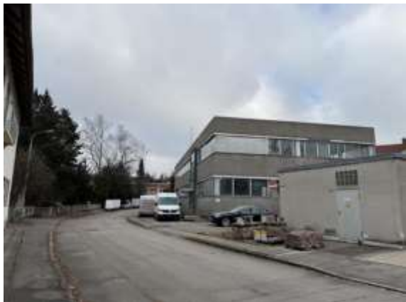
Ansicht Betriebsgebäude mit Trafostation
