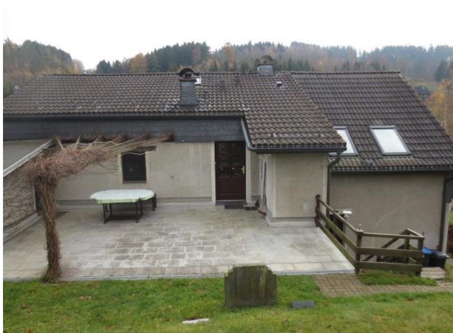
Gebäuderückseite Wohnhaus mit Hauszugang Dachgeschoss
