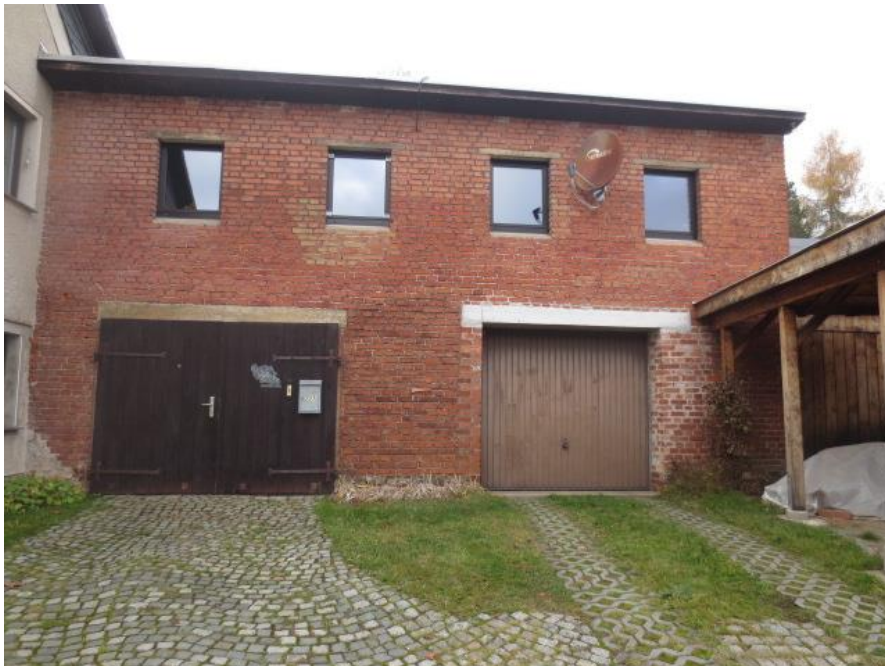
Seitengebäude (nördlicher Anbau)
