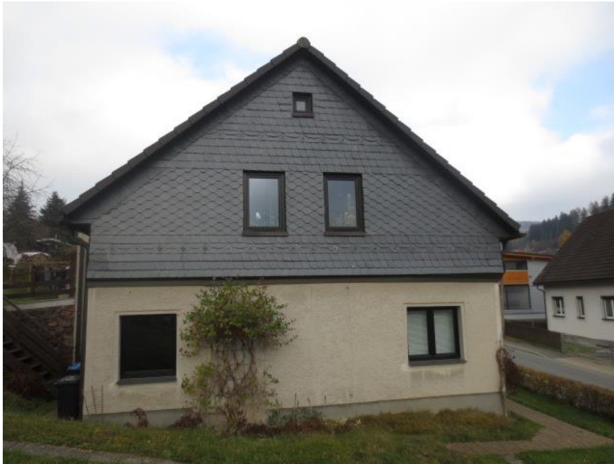
südliche Giebelseite Wohnhaus
