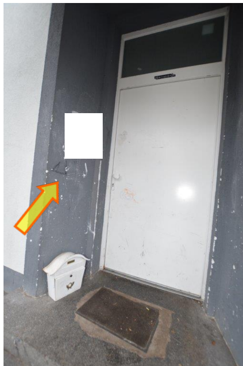
Außenputzschäden (Beispiel)
