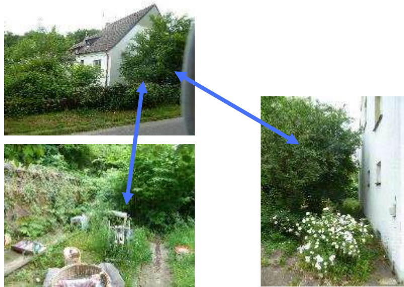
Blick vom Innenhof (Bereich zwischen Straße und Giebelseite Bewertungsobjekt)
