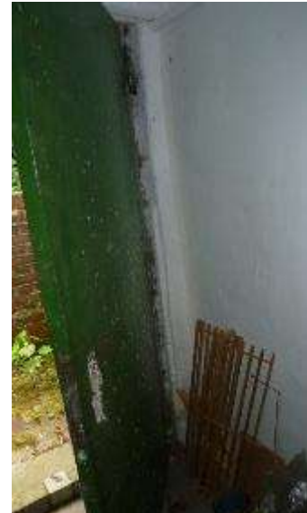
Kelleraußentreppe z.T. Risse im Wandbereich sowie Tür zum separatem Kellerraum defekt.
