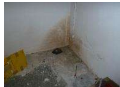
Separater Kellerraum (mit Gewölbedecke), tlw. starke Verfärbungen im Wand- / Sockel- und Bodenbereich (dieser Raum ist lediglich über die Kelleraußentreppe zu erreichen)
