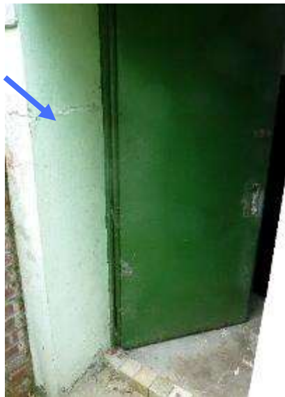
Kelleraußentreppe z.T. Risse im Wandbereich sowie Tür zum separatem Kellerraum defekt.
