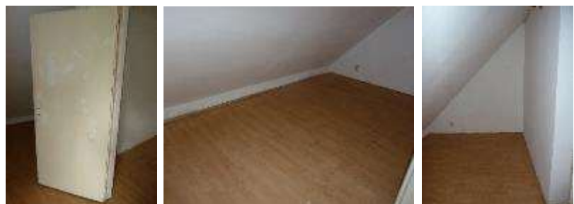
Raum ohne Heizkörper, sonst Zustand Tür, Elektro sowie Oberboden wie vorher bereits beschrieben.
