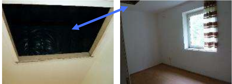
Luke zum Spitzboden (keine Einschubtreppe und/oder Leiter vorhanden)
