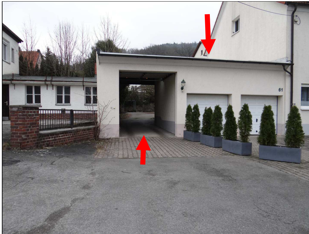
Bild 5: Süd-West-Ansicht der Zufahrt Fl.Nr. 2471/5 und der Garage Fl.Nr. 2471/10
