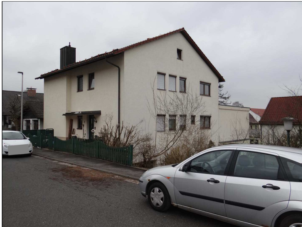
Bild 1: Blick auf das Wohngebäude von Norden
