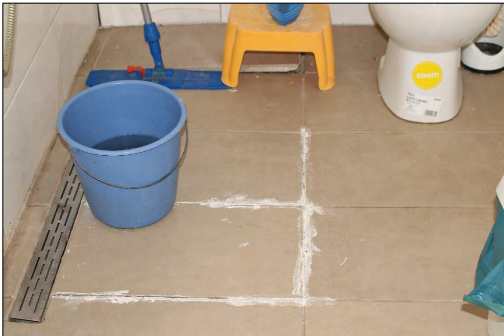
Foto Nr. 34: ETW Nr. 16, 2. OG links, bodengleiche Dusche
