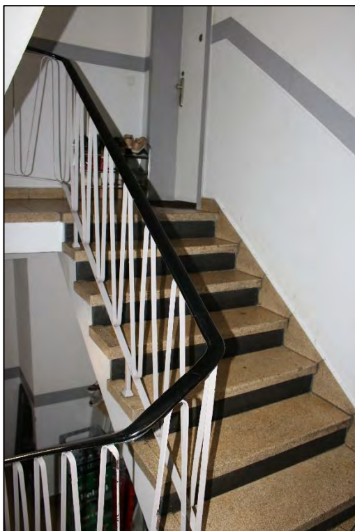
Foto Nr. 26: Gemeinschaftstreppehaus
