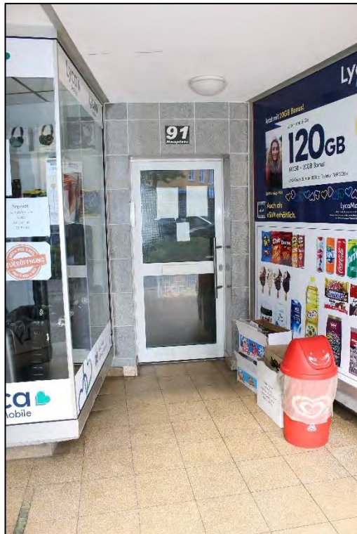
Foto Nr. 3: Hauseingang, Hauptstraße 91
