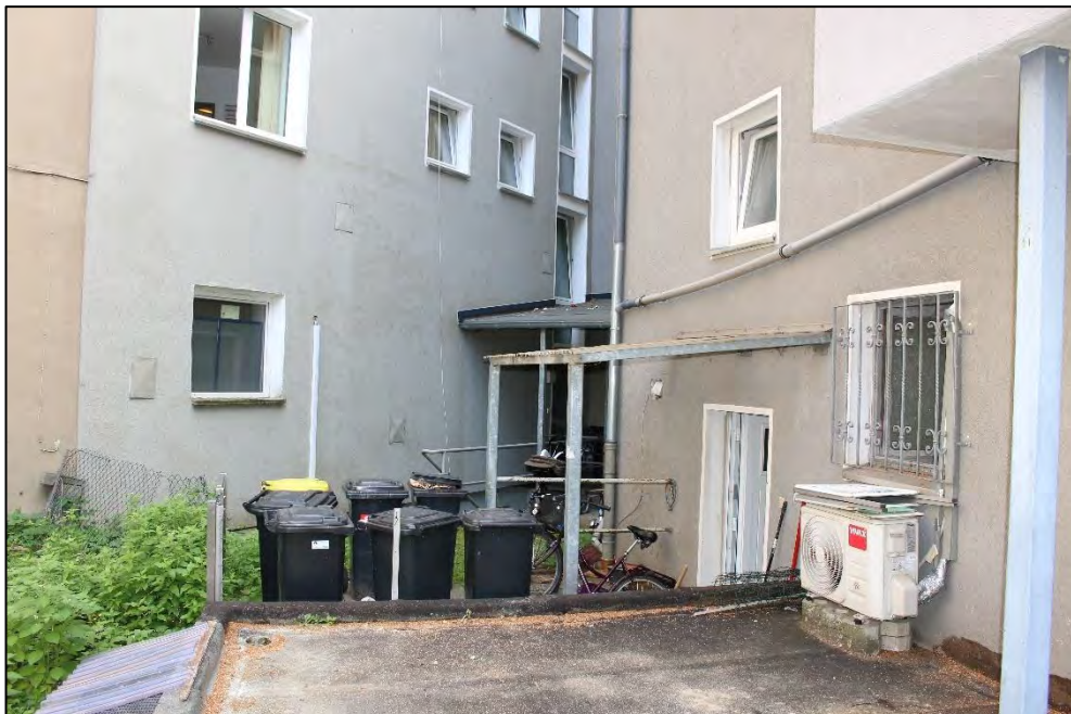
Foto Nr. 6: Hoffassade Florastraße / Hauptstraße
