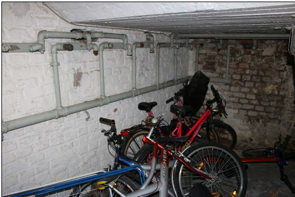
Foto Nr. 16: Kellergeschoss, Flur
