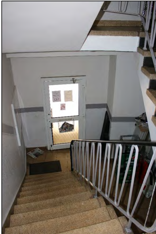
Foto Nr. 25: Gemeinschaftstreppehaus
