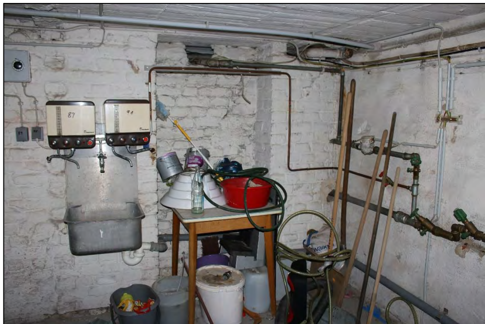
Foto Nr. 20: Kellergeschoss, Waschküche
