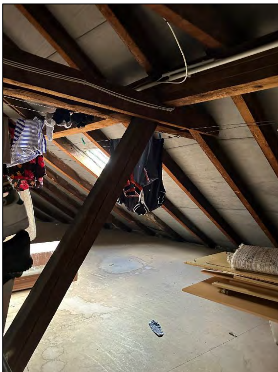
Foto Nr. 42: Dachboden
