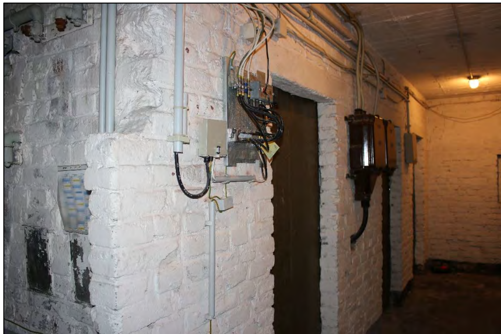
Foto Nr. 24: Kellergeschoss, Flur
