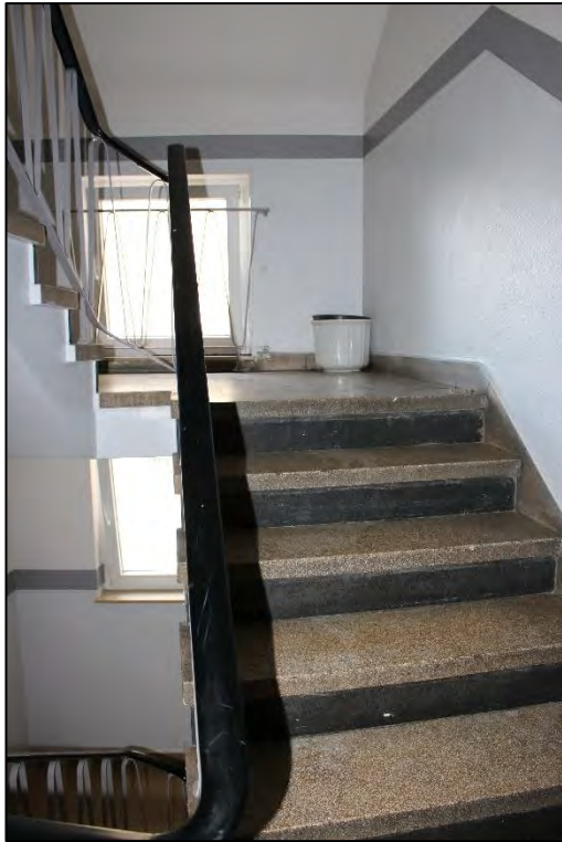
Foto Nr. 41: Gemeinschaftstreppehaus
