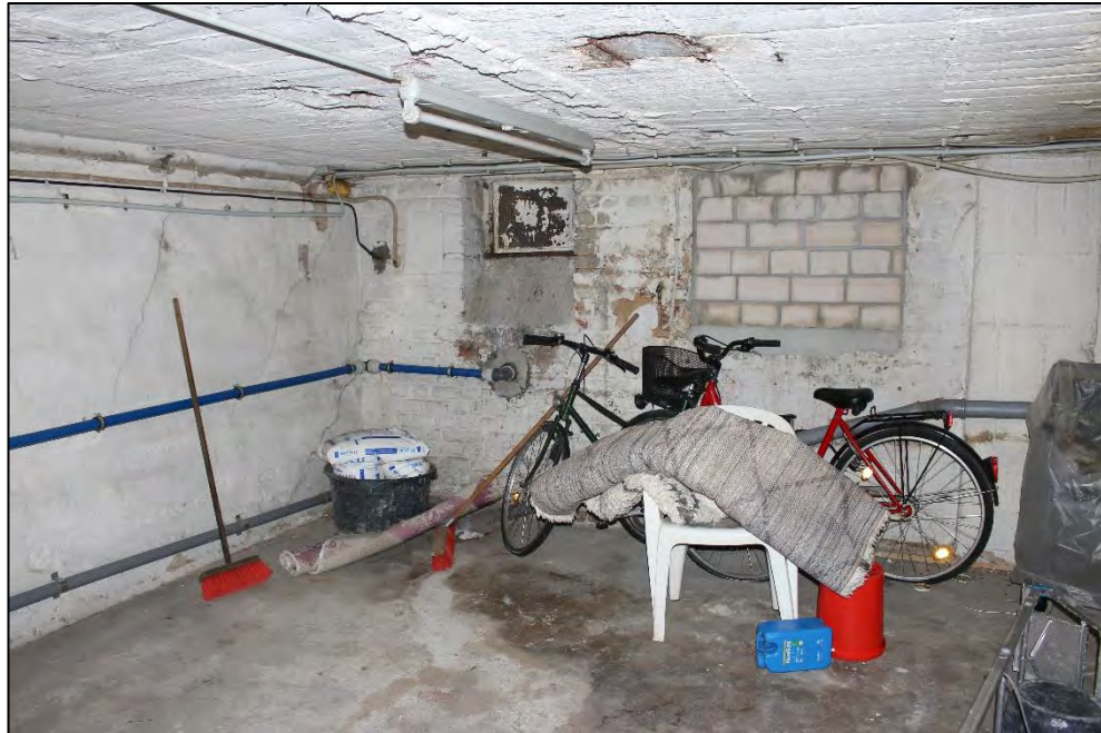
Foto Nr. 19: Kellergeschoss, Waschküche
