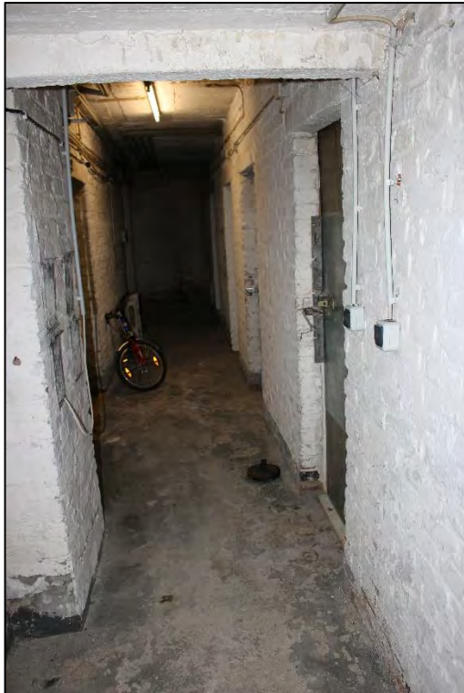
Foto Nr. 21: Kellergeschoss, Flur
