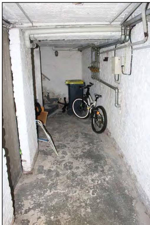
Foto Nr. 18: Kellergeschoss, Flur
