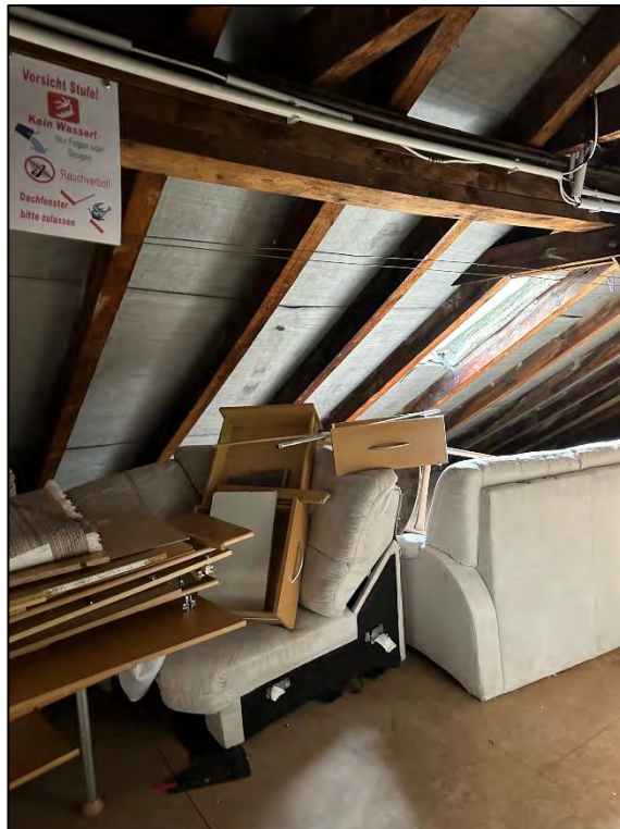
Foto Nr. 43: Dachboden
