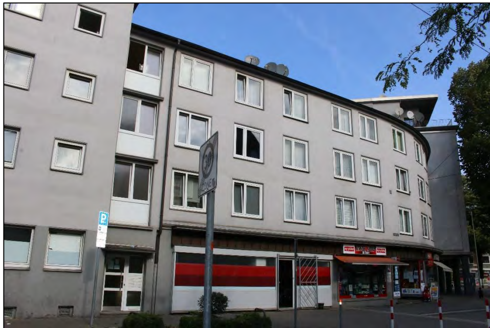
Foto Nr. 1: Straßenfassade, Hauptstraße
