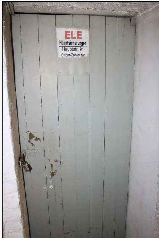
Foto Nr. 23: Kellergeschoss, Zugang zum Hausanschlussraum
