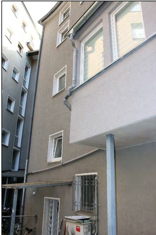
Foto Nr. 5: Hoffassade Florastraße / Hauptstraße
