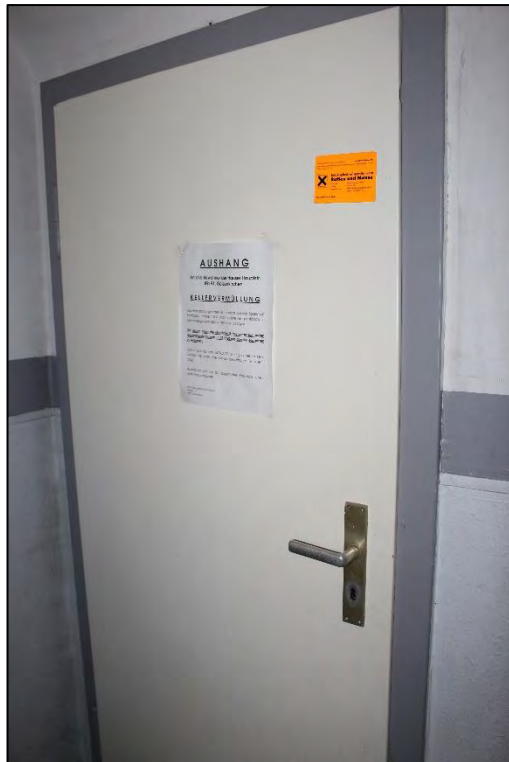
Foto Nr. 13: Gemeinschaftstreppe, Tür zum Kellergeschoss
