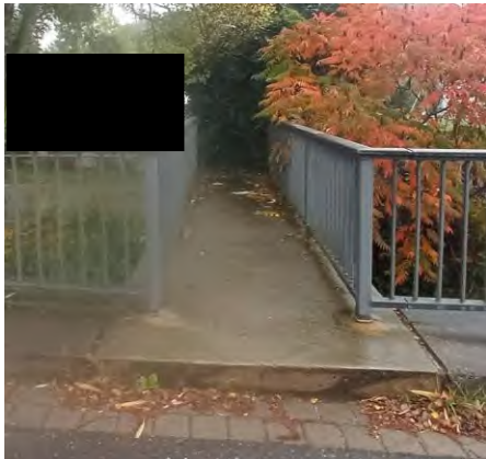
31 – öff. Brücke über Bach
