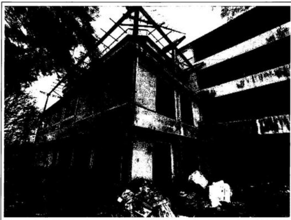
Blick auf das Bewertungsobjekt von Nordosten (Eingangsbereich)
