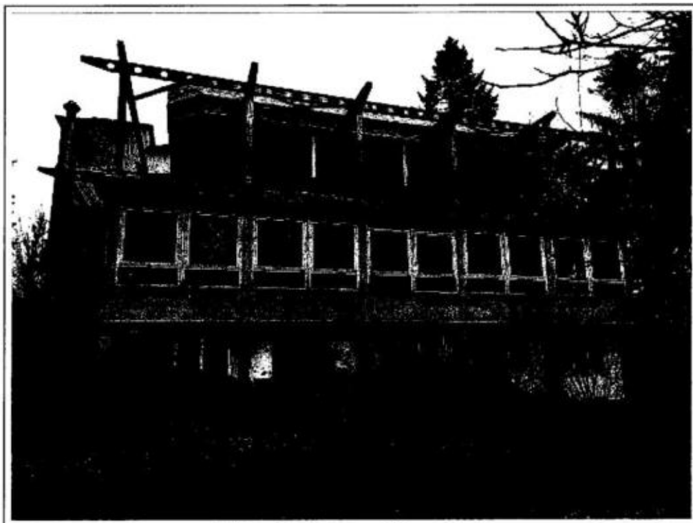
Blick auf das Bewertungsobjekt von Süden
