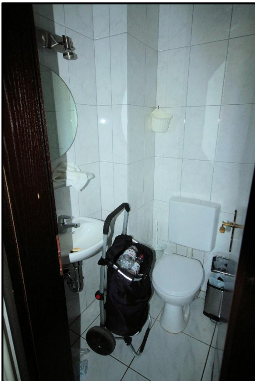
Bild 20: WC des Wohnungseigentums Nr. 1 im Erdgeschoss links
