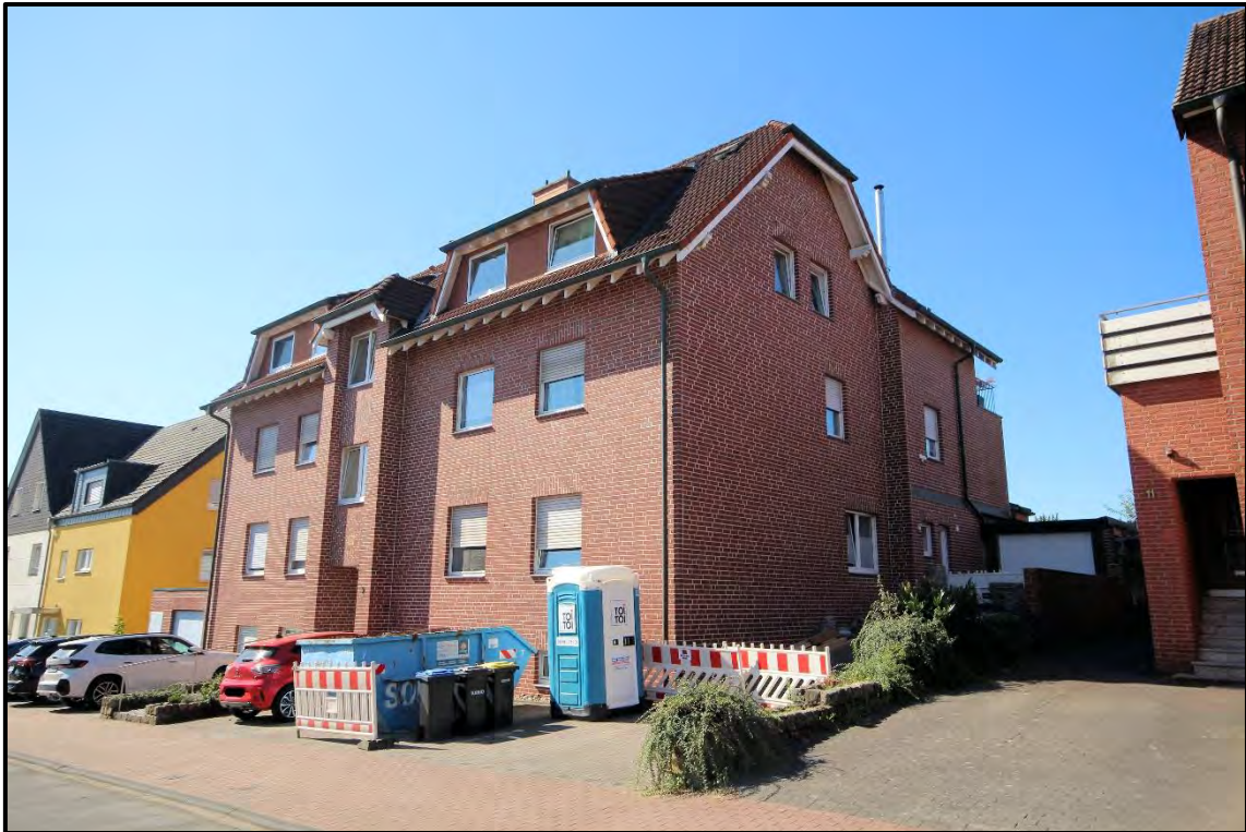
Bild 5: Ansicht von Norden
