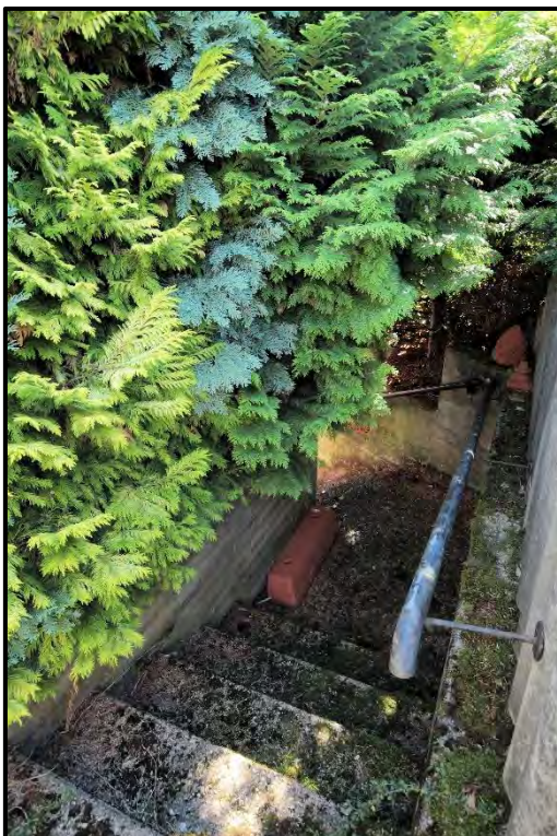
Bild 12: Gartentreppe des Wohnungseigentums Nr. 1 zur Garage Nr. 7
