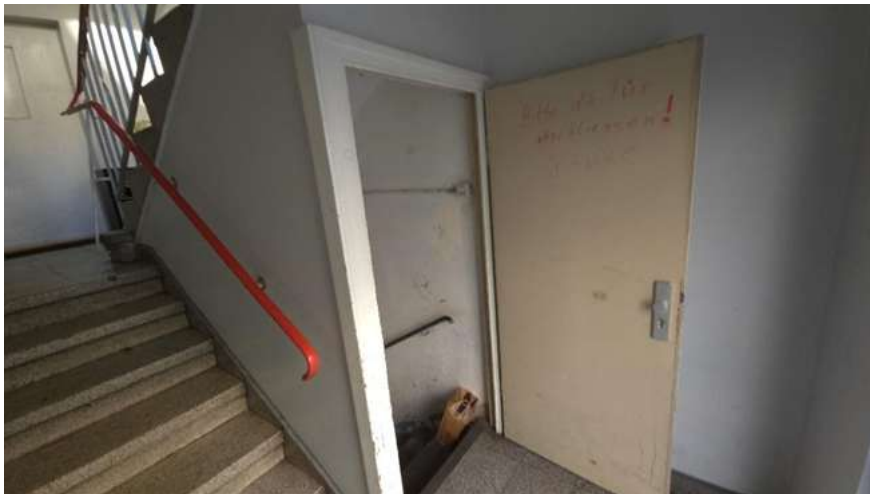
Treppenhaus im Hauseingangsbereich.
