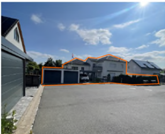
Blick über den Wendehammer zum Bewertungsgrundstück
