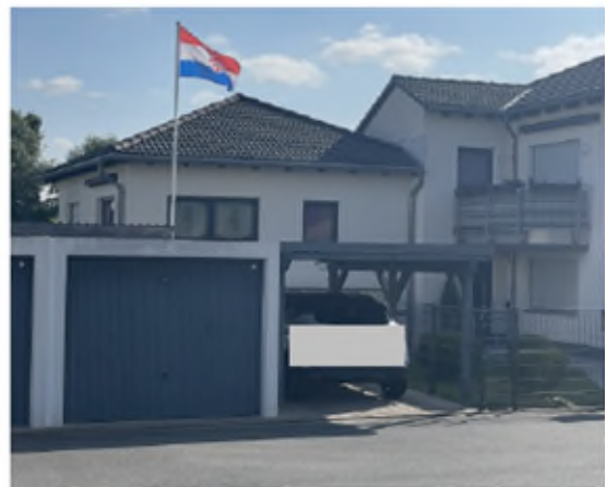
Straßenseite Bewertungsgrundstück, Garagen, Carport, Zugang WH
