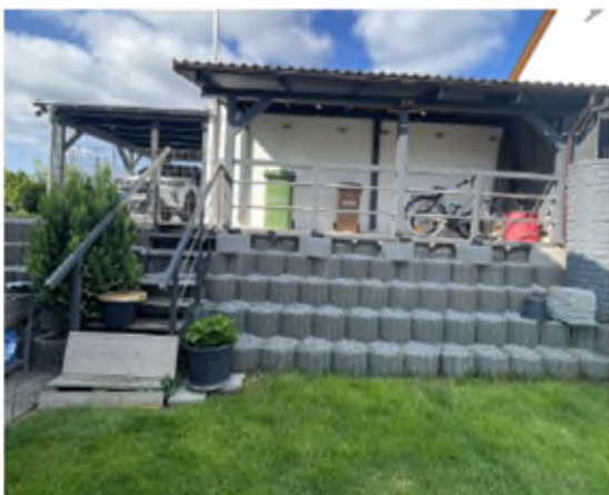
Fassade NO der Garagen mit Carport
