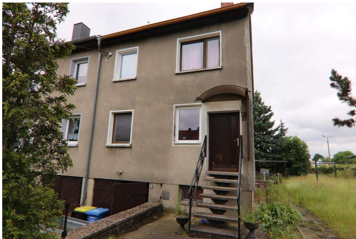
Blick auf die Nordseite des Reihendhauses des zu bewertenden Grundstücks Am Hopfenberg 10 in Görlitz OT Ludwigsdorf.
