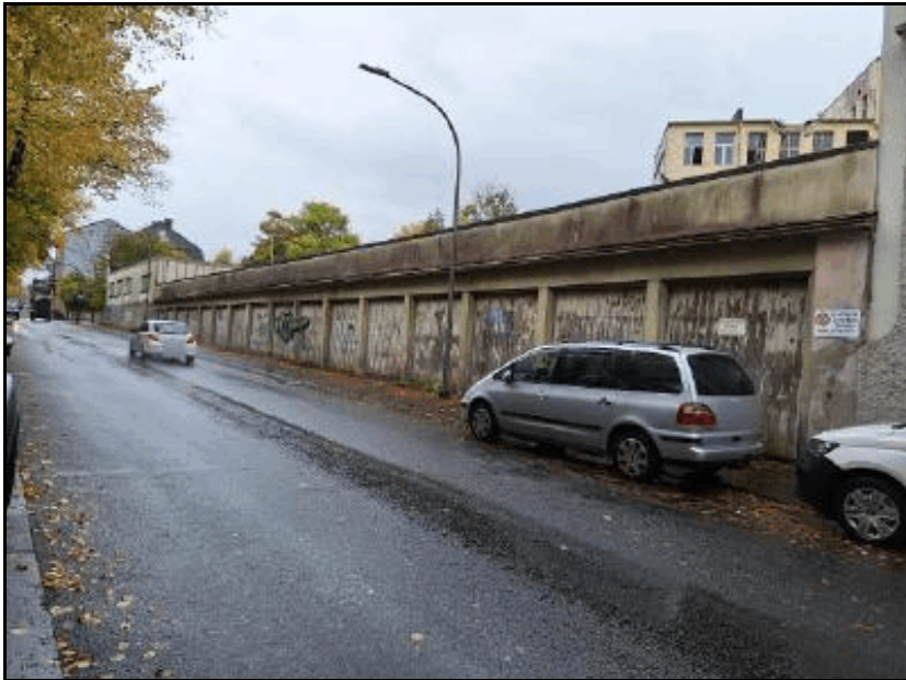
Foto 10: Reihengaragen an der Ritterstraße
