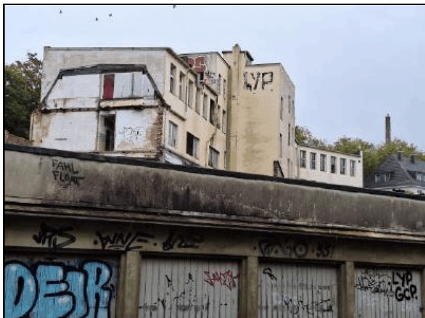
Foto 7: Ansicht Rückseite Christbusch 6 und 8 von der Ritterstraße
