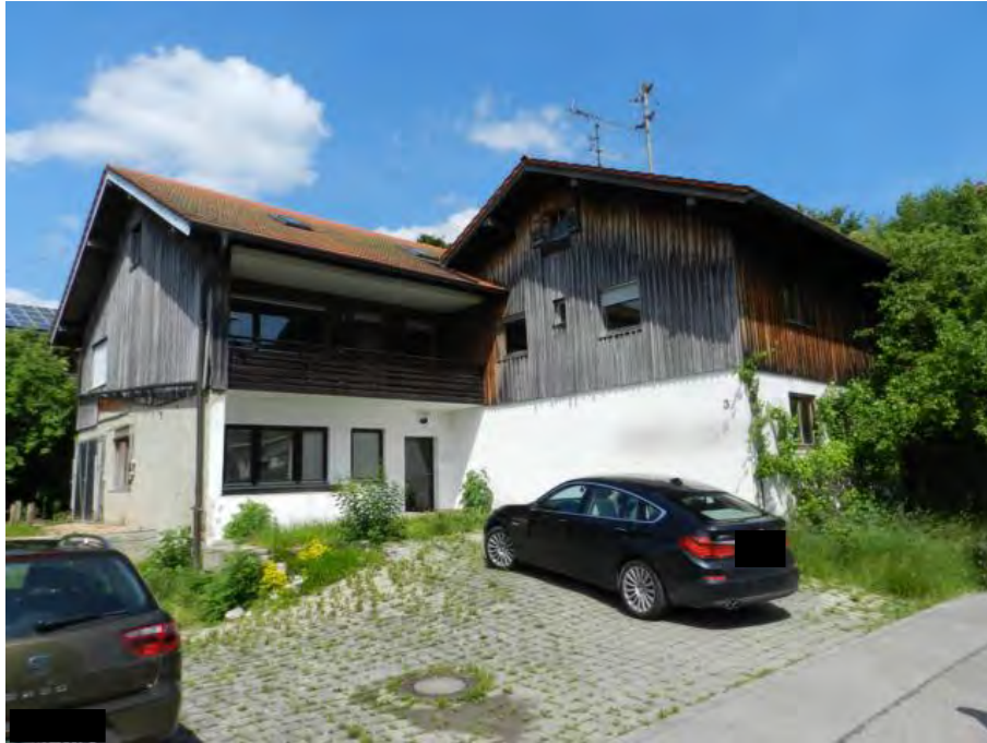
Ansicht auf Südfassade und Westgiebel
