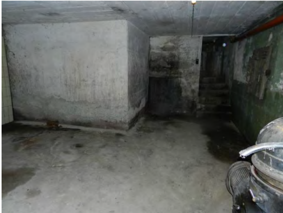
Kellerraum; hinten rechts Treppe zum EG
