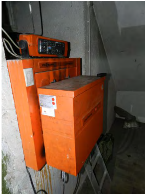
Erdgeschoss, gewerbliche Nutzflächen; Heizkessel
