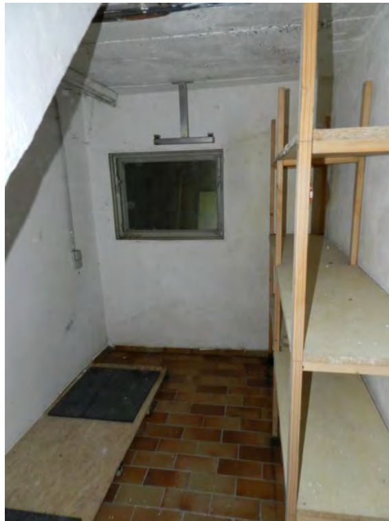
Kellerraum, südlicher Gebäudeteil
