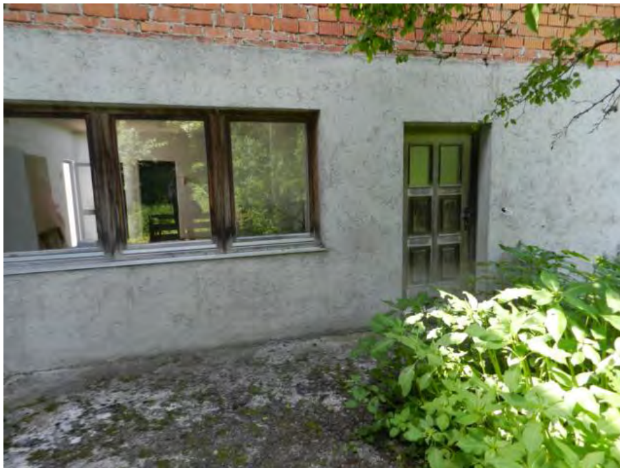
Haustüre in Ostfassade (Ostgiebel) zum Treppenhaus (Whg. OG, West)
