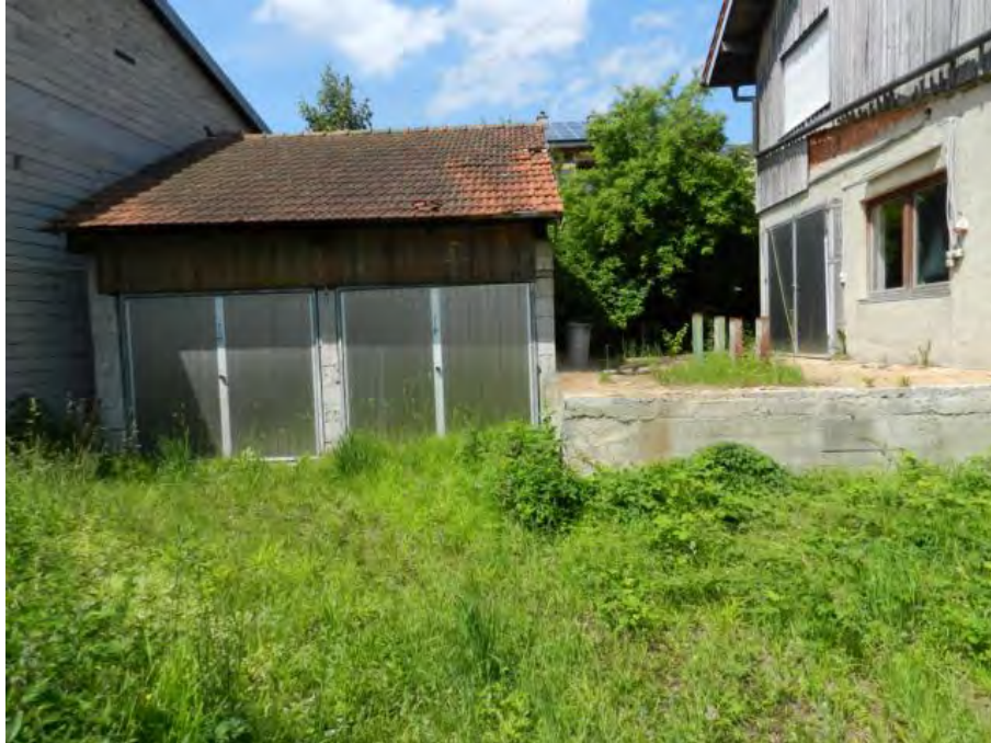
Ansicht Garage West
