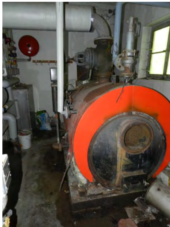
Erdgeschoss, gewerbliche Nutzflächen; alter Kessel
