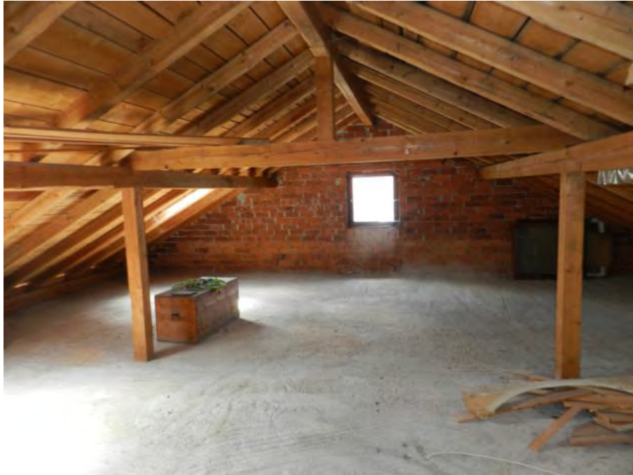
Dachboden, nördlicher Gebäudeteil
