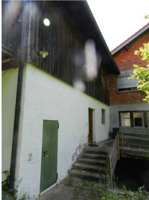
Nordfassade, Haustüre zur Wohnung OG/DG (Ost)
