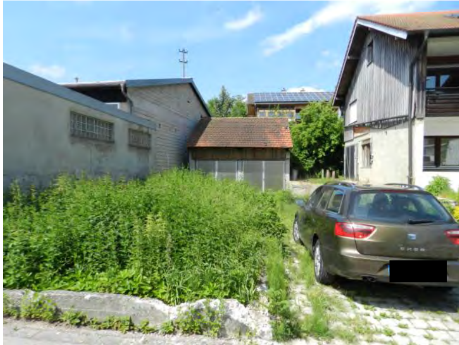
Blick auf Garage West
