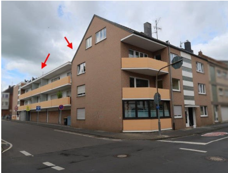
Bild 1 Außenansicht Ecke Mittelstraße - Mühlenstraße
