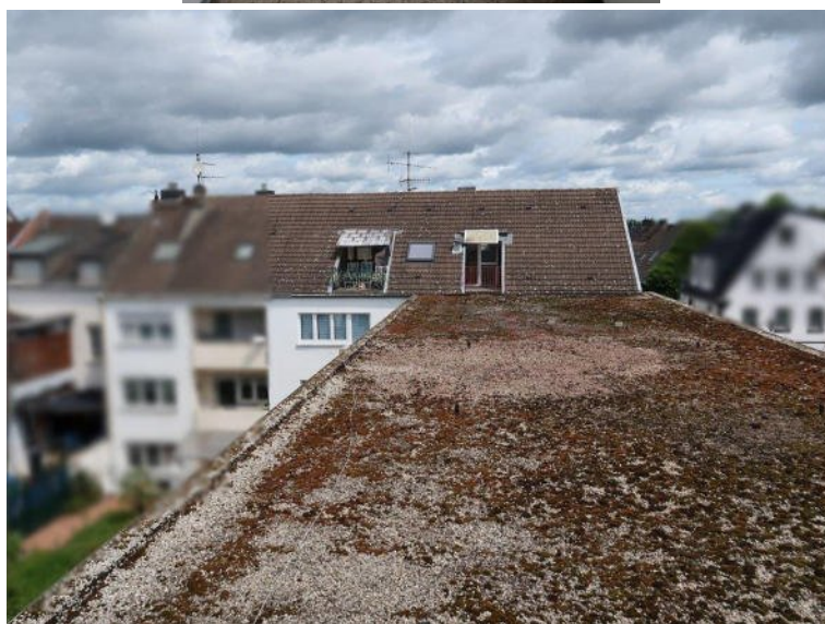
Bild 9 Flachdach Mittelstraße 31 und Blick auf Mühlenstraße 28
