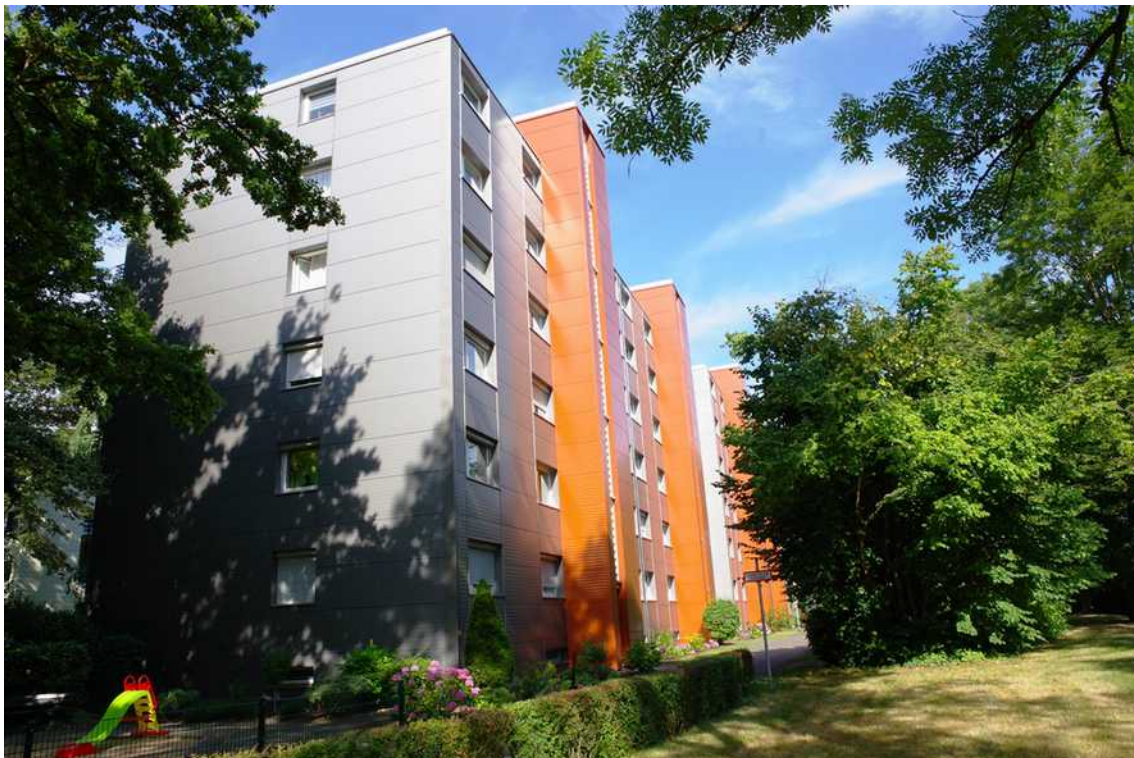
Bild 4: Übersichtsaufnahme des Gebäudekomplexes Hasenbleiche 9, 11, 13, 15 aus Südost
