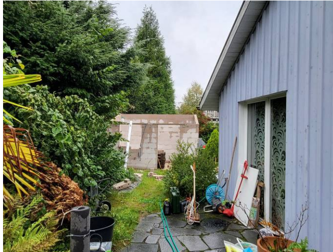
Garten Richtung Norden (Gartenhaus im Bau)
