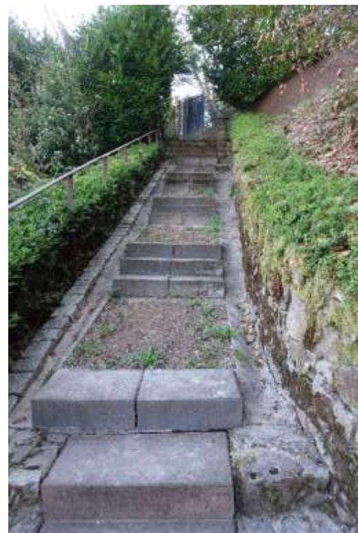
10.2.10 Weg auf dem Flurstück 280/233, Blick Richtung Nordosten zum Tor am Wirtschaftsweg
