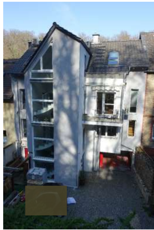
10.2.8 Hofansicht, Blick vom südöstlichen Grundstücksbereich 280/234 Richtung Nordwesten
