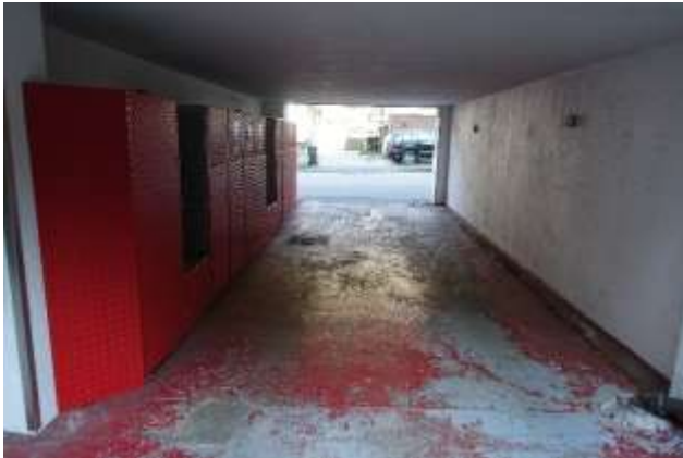
10.2.17 Durchfahrt an der nordöstlichen Grundstücksgrenze, Blick vom Hof zur Straße
