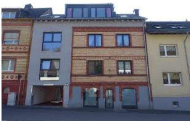
10.2.5 Nordwestfassade zur Straße, Blick vom gegenüberliegenden Gehweg Richtung Südosten
