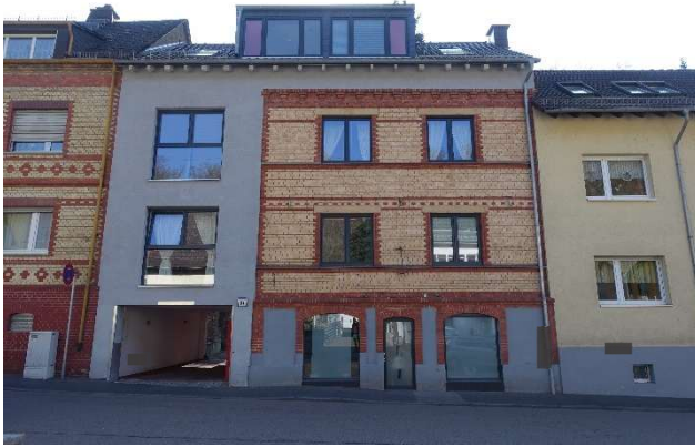
Nordwestfassade zur Straße, Blick vom gegenüberliegenden Gehweg Richtung Südosten
