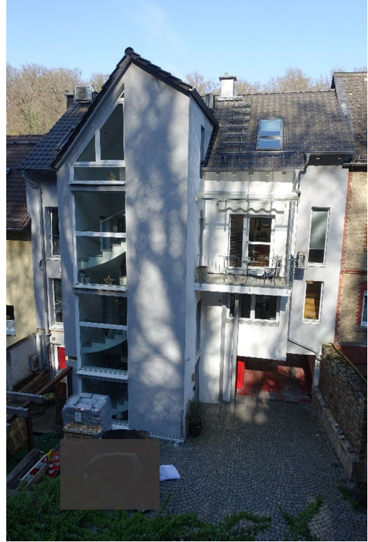
Hofansicht, Blick vom südöstlichen Grundstücksbereich 280/234 Richtung Nordwesten
