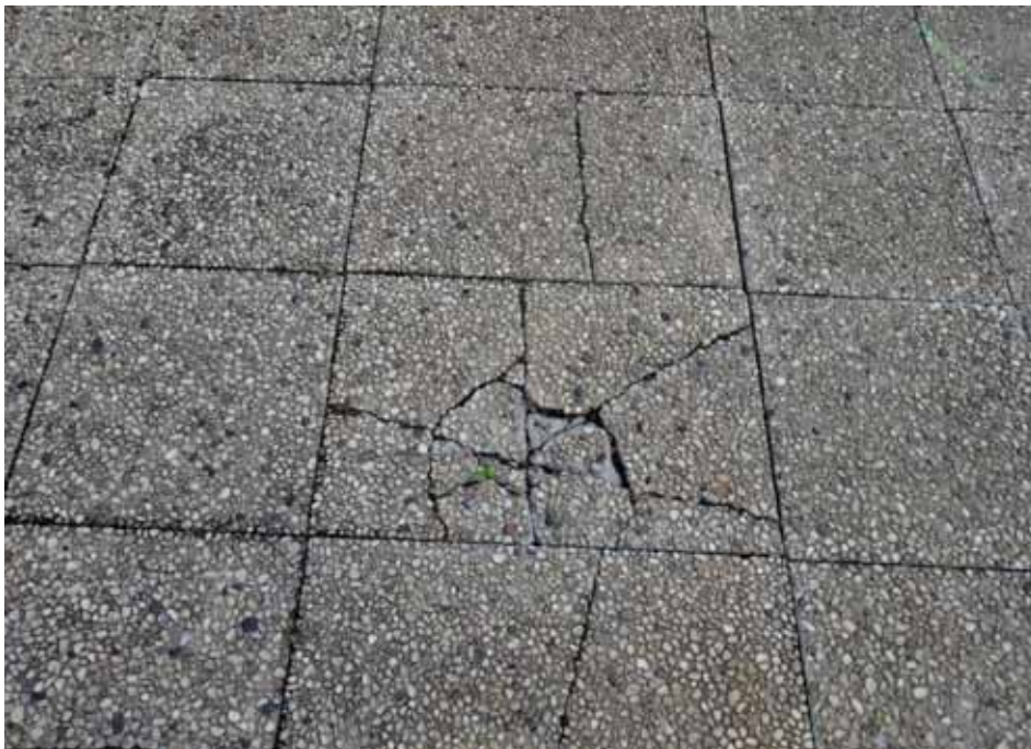
beschädigter Bodenbelag der Zufahrt
