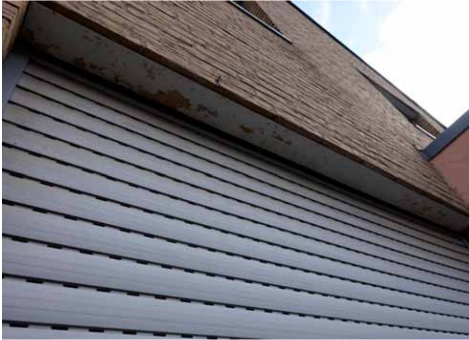
stellenweise beschädigte Rollladenkasten-Abdeckung
