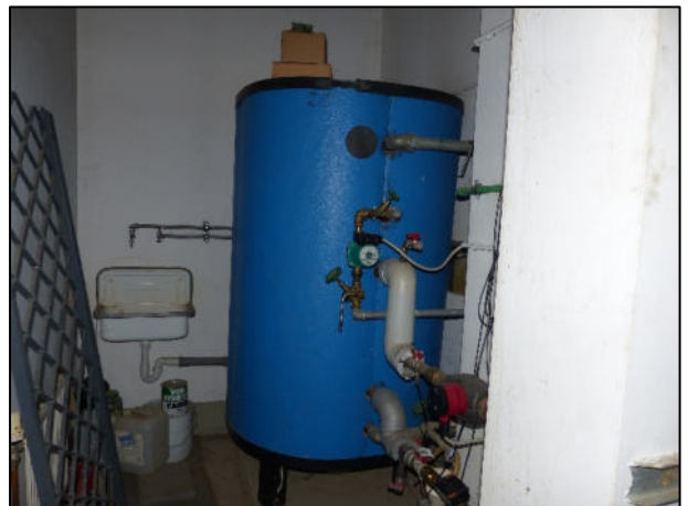
Bild 10: Techn. Ausstattung – zentraler Brauchwasserspeicher
