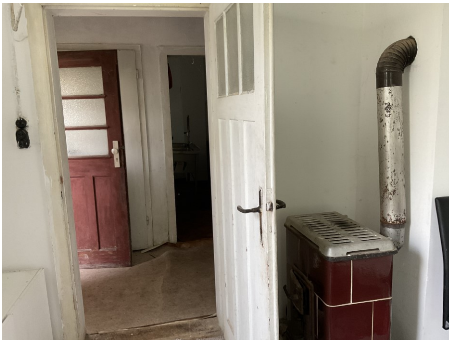
Ofenheizung, Elektro auf Putz, verschlissen,
