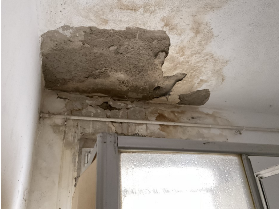
Bauschäden vorstehend Fußboden und Decke auf Grund Dachschaden
