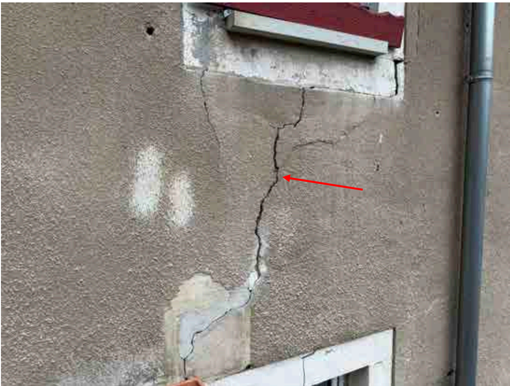
Beispiel für Risse im Außenmauerwerk; hier: an der Ostseite
