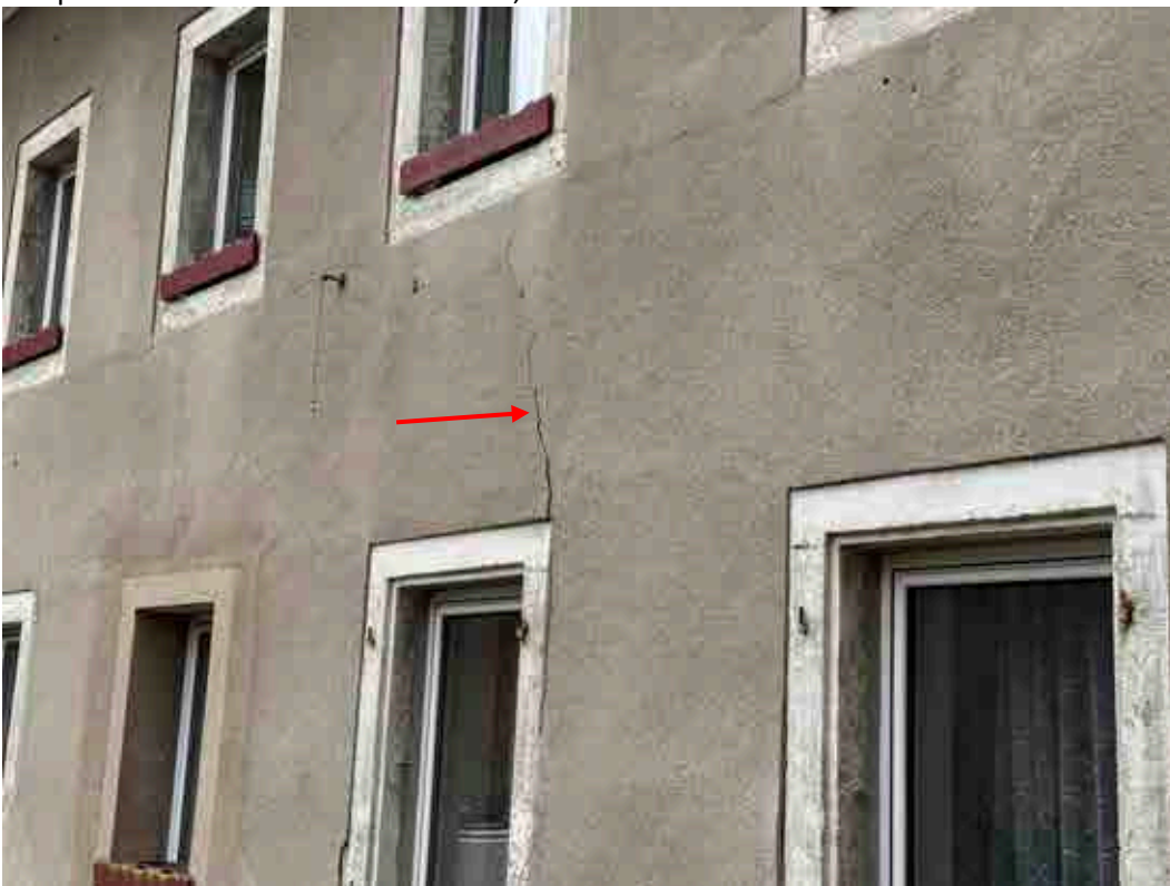
Beispiel für Risse im Außenmauerwerk; hier: an der Westseite
