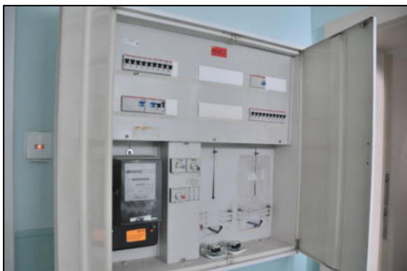
Sicherungskasten im Treppenhaus
