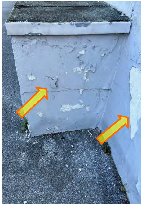
Außenputzschäden (Beispiel)
