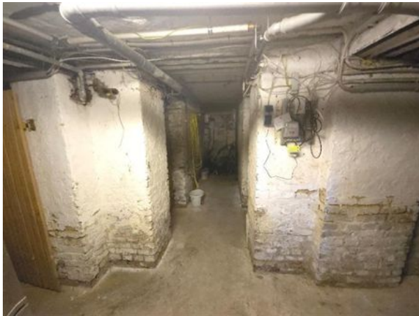
Kellerflur mit Feuchtigkeitsschäden an den Wänden.
