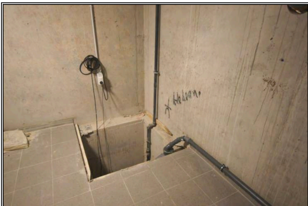
fehlende Hebeanlage
