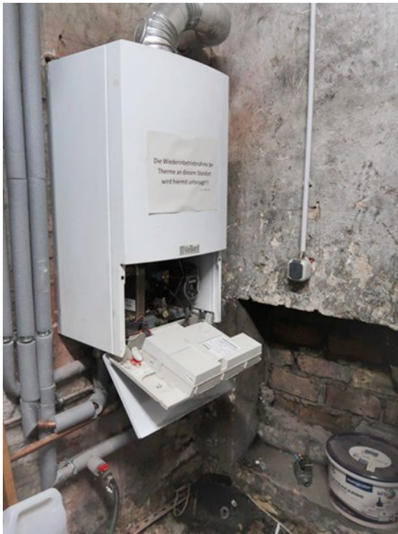
Gaskombitherme der zu bewertenden Wohnung mit Standort in fremdem Kellerraum, zum Zeitpunkt der Ortsbesichtigung außer Betrieb
