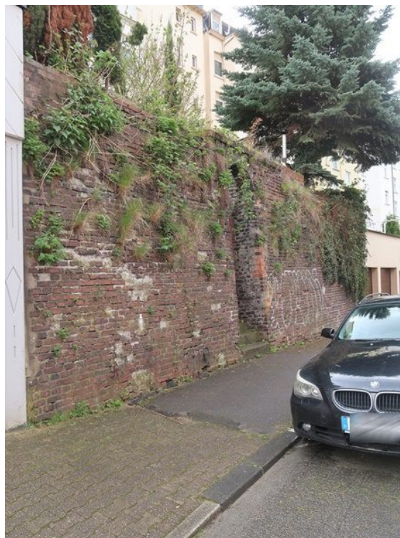
Stützmauer Hagener Straße, ebenfalls mit Fehlstellen und Feuchteschäden
