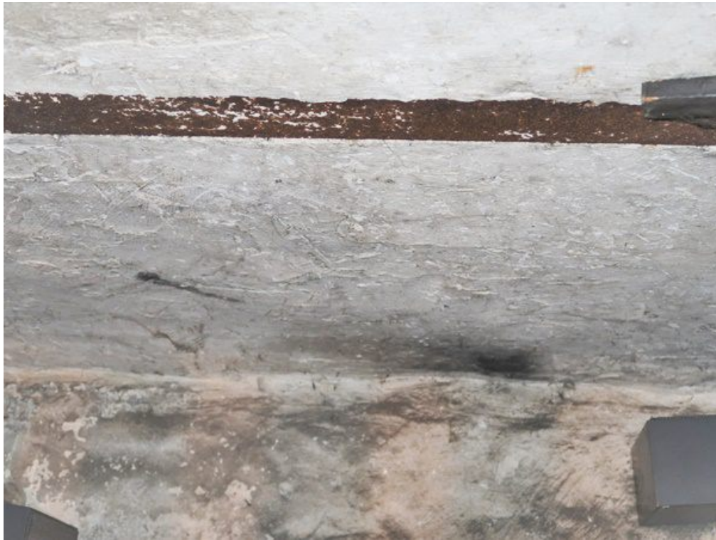
Teilansicht Kellerdecke: Stahlträger mit Korrosionsbefall
