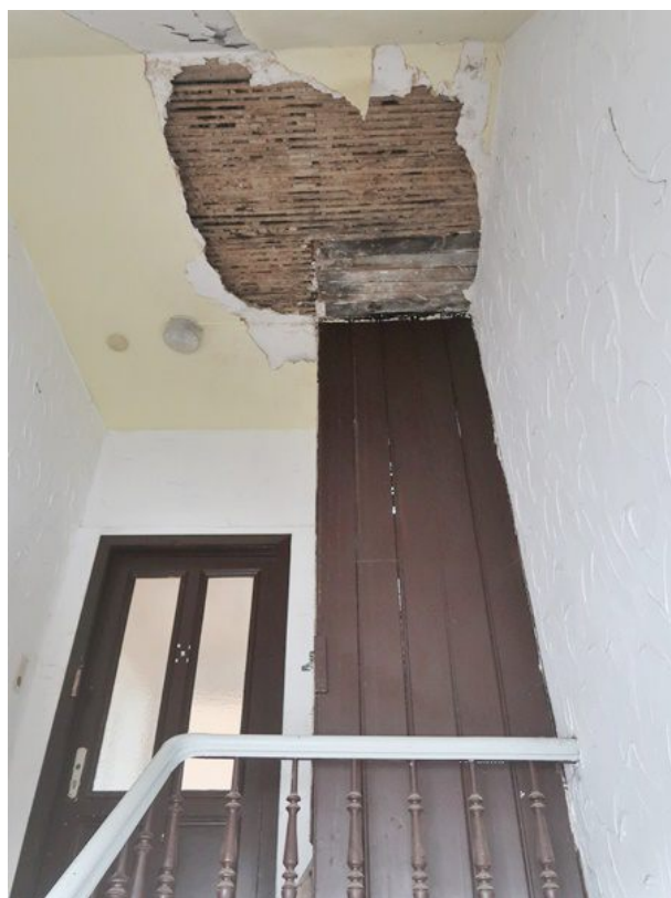
Putzschaden im Treppenhaus Dachgeschoss
