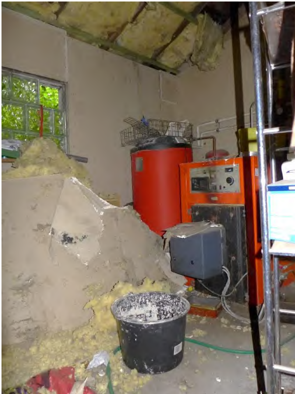
21 Heizungsraum, schadhafte Dämmung und Verkleidung
