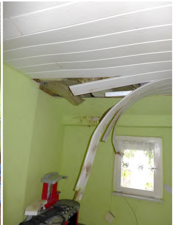
16 b schadhafte Paneelen (Wasserschaden)
