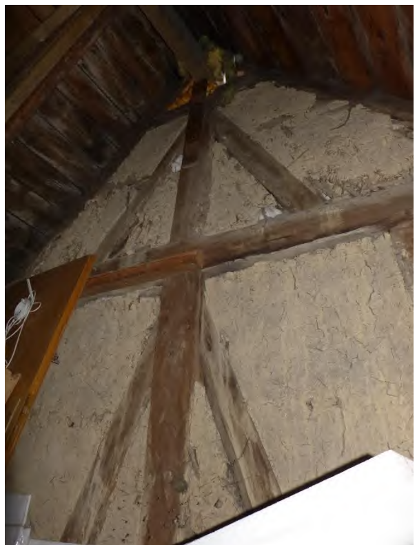
20 b Giebelwand mit Lehmausfachung
