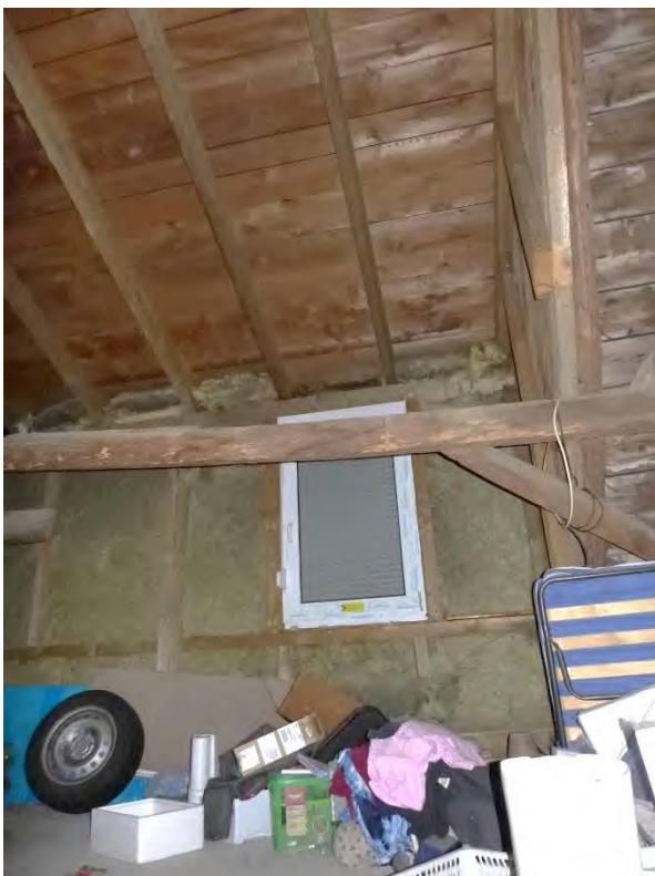
20 a Gaube mit Dämmung
