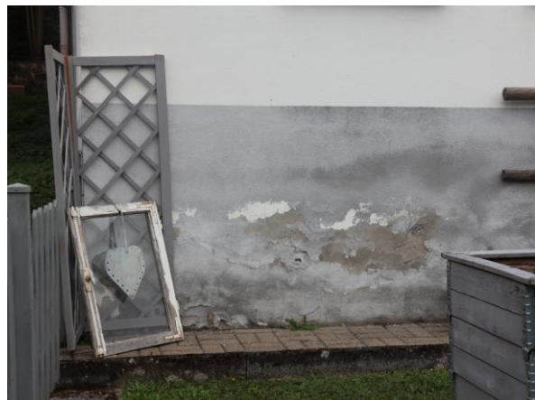
wie vor, Detail/Sockelfeuchte
