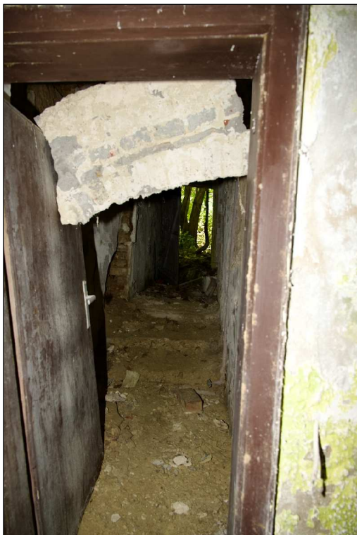
Foto 10 Erdgeschoss - Durchgang zum Garten, eingestürzter Sturz
