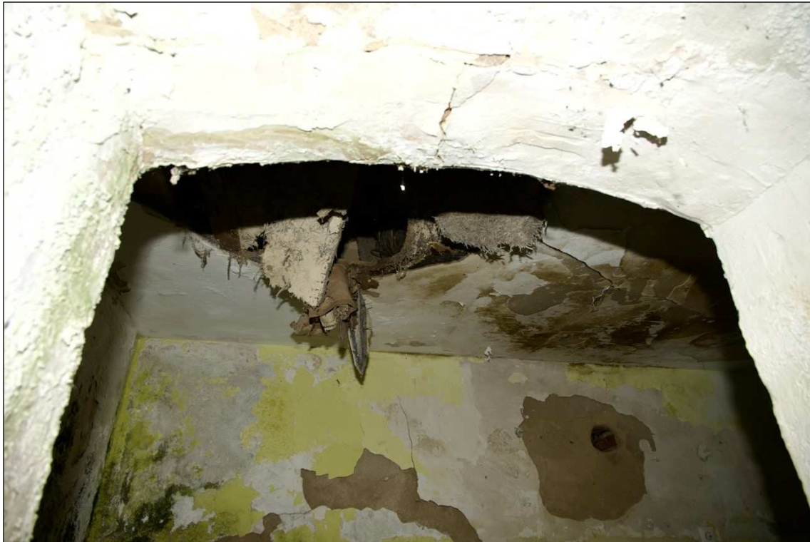
Foto 11 Erdgeschoss - Deckeneinsturz
