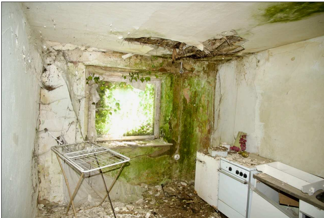
Foto 6 Erdgeschoss - Zimmer, Deckeneinsturz
