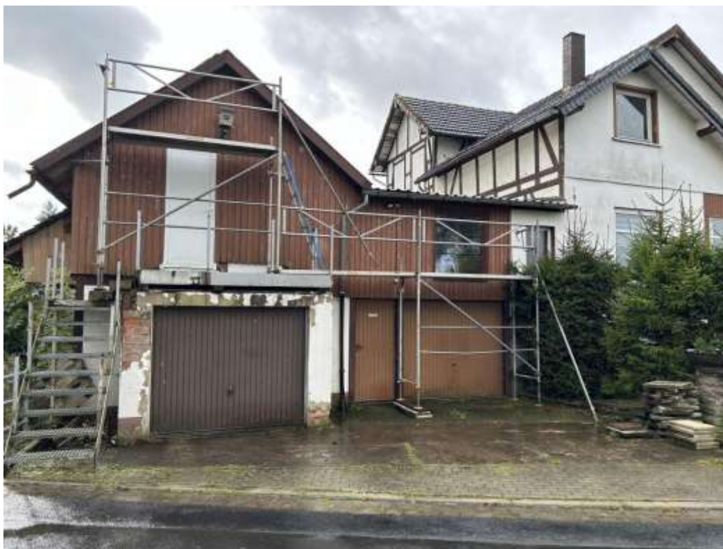
14: 14 Detail Zugang Partyraum ohne adäquate Absturzsicherung, Geländer, etc.
