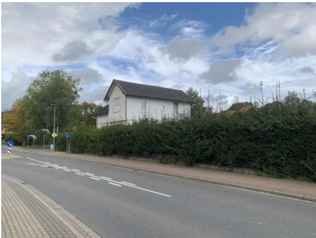
Anlage 5.2: Bild 2 Ansicht von Südwesten
