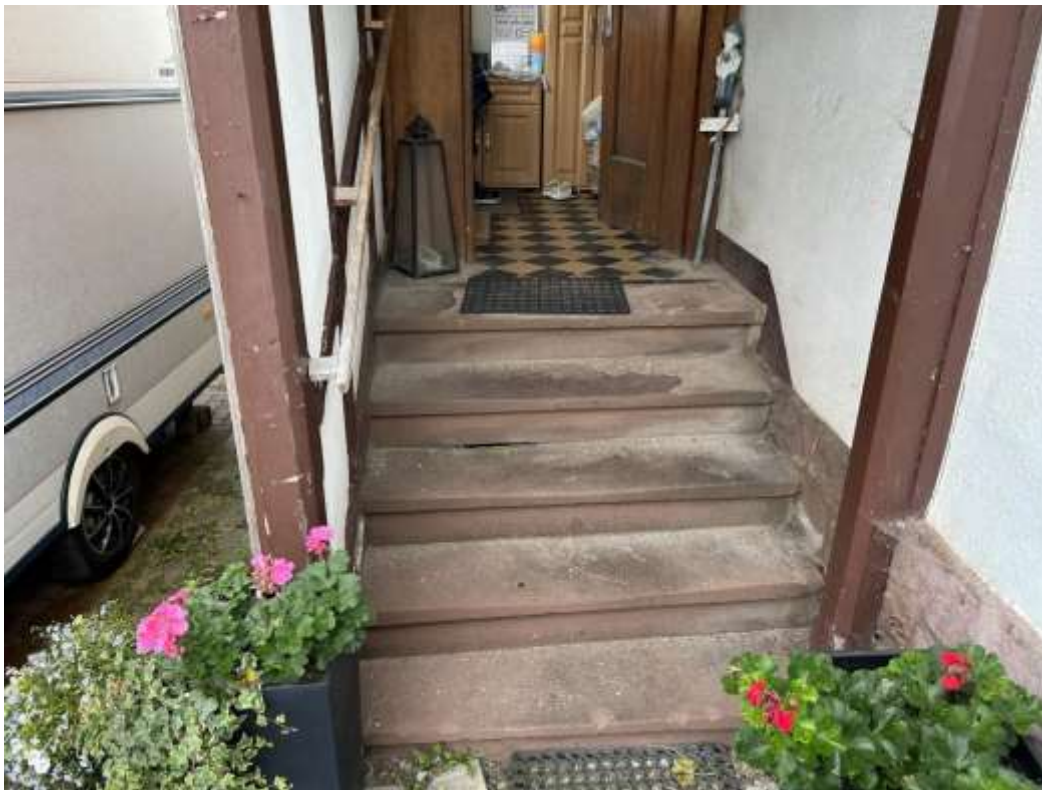
Anlage 5.5: Bild 5 Hauseingangsbereich
