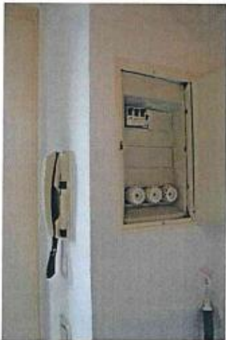
Elektro-Unterverteilung/Gegensprechanlage
