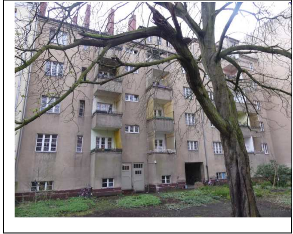
Hofansicht mit Balkonen
