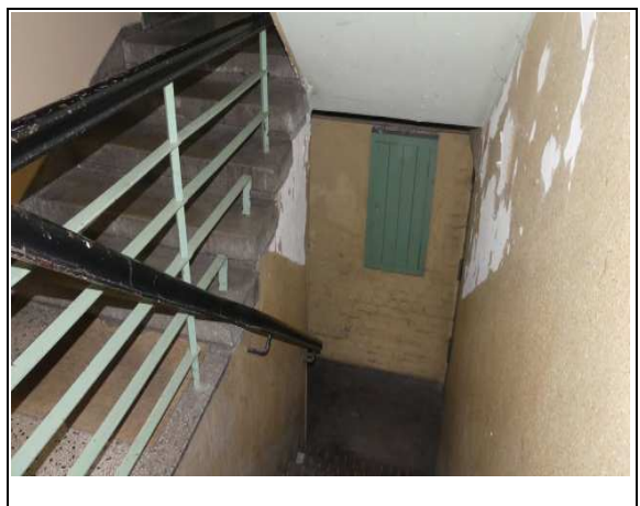
Kellerzugang vom Hof
