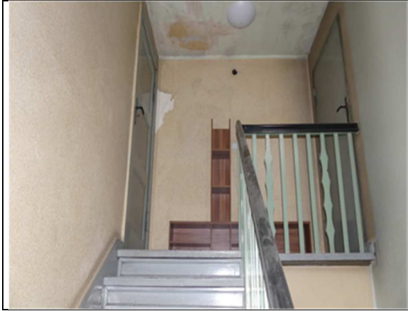
Treppenhaus zum Dachboden
