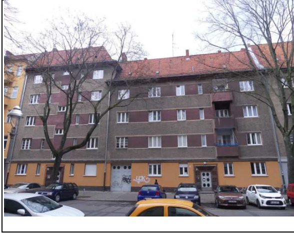
Straßen Ansicht beider Vorderhäuser
