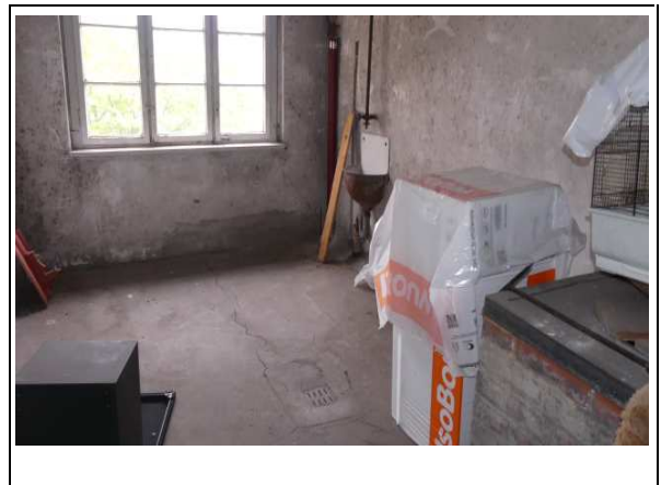
Ehemalige Waschküche im DG
