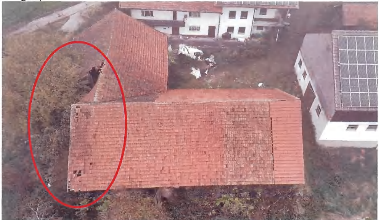
Bild 15: Ansicht des L-förmigen Scheunenkomplexes (Gebäude 2/1 und 2/2) von Süden, Blickrichtung Norden. Die Schäden an dem Gebäudekomplex sind gravierend, der südwestliche Gebäudeteil ist bereits eingestürzt.
