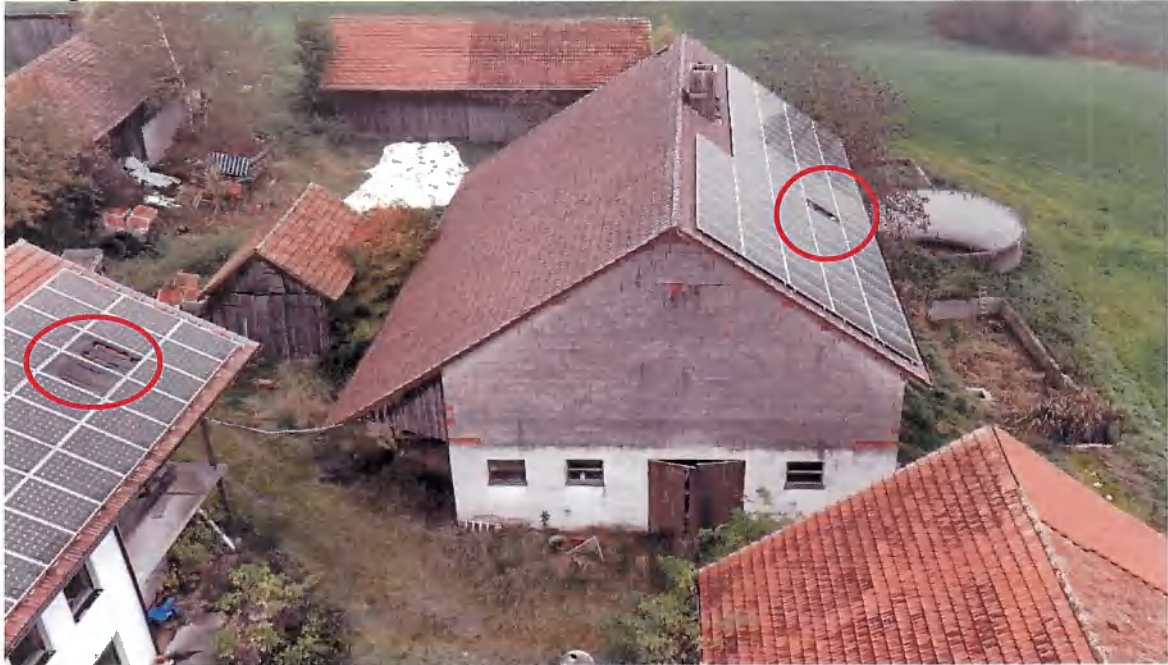
Bild 17: Ansicht des zweigeschossigen und damit deckenlastigen Rinderstalles (Gebäude 3) von Westen, Blickrichtung Osten. Im Bild die westliche Giebelseite des weitgehend in massiver Bauweise errichteten, ehemaligen Stalles mit dem Einfahrttor an der Westseite. Die Giebelwand an der Westseite ist gemauert.
