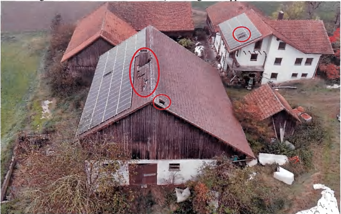
Bild 20: Ansicht des zweigeschossigen Rinderstalles (Gebäude 3) von Osten, Blickrichtung Westen. Im Bild die östliche Giebelseite des Stalles, hier nur im Erdgeschossbereich gemauert, mit dem Einfahrtstor an der Ostseite. Schäden an der Dachdeckung sind vor allem im Firstbereich zu erkennen. Rechts vom Stall der kleine, baufällige Holzschuppen (Gebäude 4). Der Stall hat höchstwahrscheinlich eine Stahlbetondecke zum Obergeschoss und diese liegt vermutlich auf Stahl- oder Betonstützen auf.
