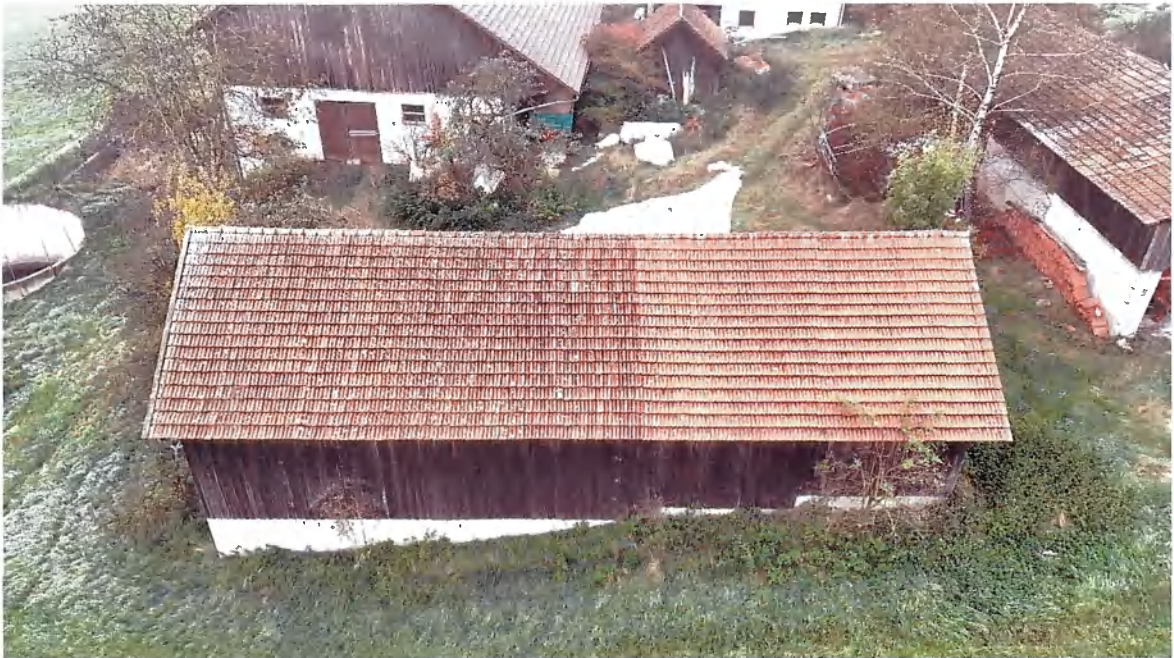
Bild 22: Ansicht der in zwei Bauabschnitten erstellten Maschinenhalle von Osten, Blickrichtung Westen (Gebäude 5). Der südliche Gebäudeteil (links) ist etwa um 1970 und der nördliche Gebäudebereich (rechts) ist etwa 1985 errichtet worden.
