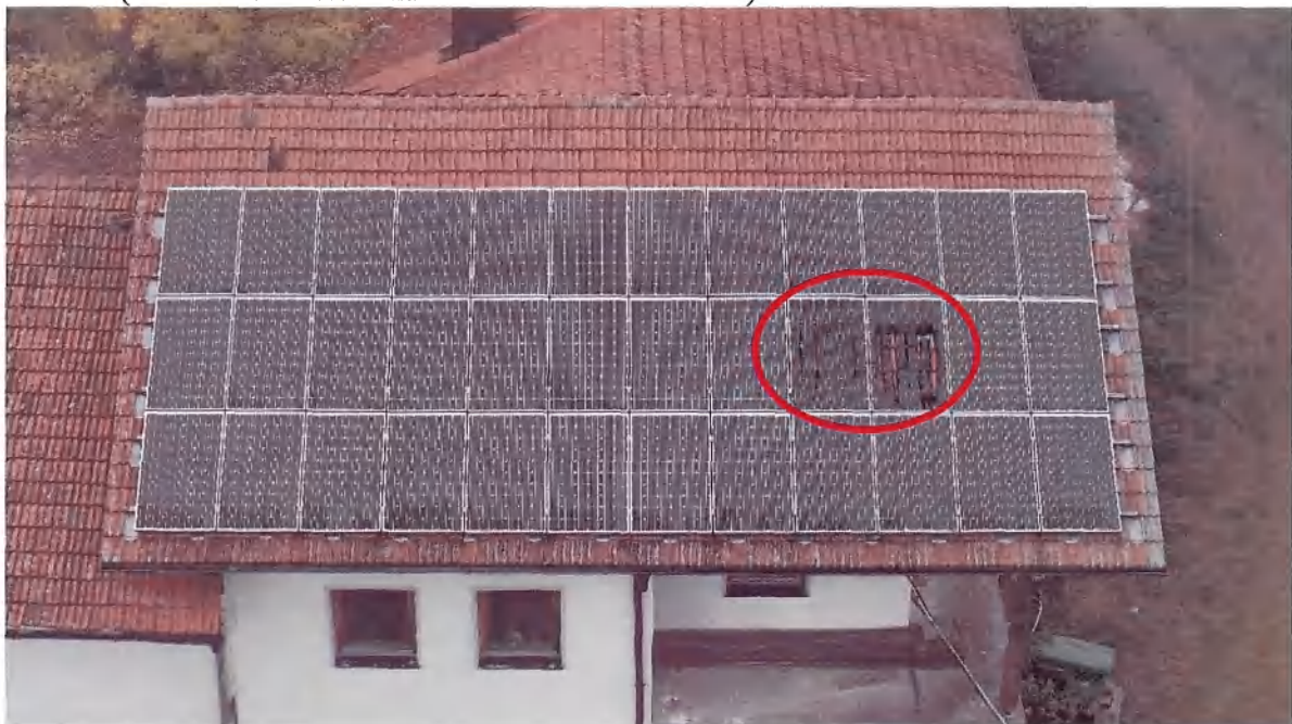
Bild 6: Dito Bild 5, Blickrichtung Norden. Im Bild der im Jahr 1989 erbaute Ostteil (Gebäude 1/2) mit der auf der Südseite des Daches montierten Photovoltaikanlage. Zwei der insgesamt 36 Module sind zerstört (vermutlich durch Kurzschluss zerschmolzen).
