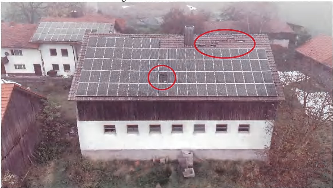
Bild 18: Ansicht des zweigeschossigen, deckenlastigen Rinderstalles (Gebäude 3) von Süden, Blickrichtung Norden. Im Bild die Südseite des ehemaligen Stalles mit der Photovoltaikanlage auf der Südseite des Daches. Eines der insgesamt 88 Module ist zerstört (vermutlich durch Kurzschluss zerschmolzen) und die Dacheindeckung aus Ton-Dachziegel weist an vielen Stellen Schäden auf. Ein Zugang zum Innenbereich des Gebäudes war nicht möglich, weswegen zur Ausstattung des Gebäudes im Innenbereich keine Aussage möglich ist.
