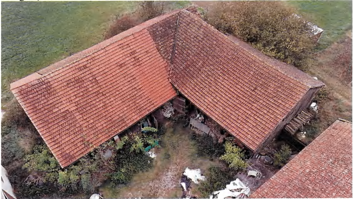
Bild 13: Ansicht des L-förmigen Scheunenkomplexes (Gebäude 2/1 und 2/2) von Nordosten, Blickrichtung Südwesten. Der ebenfalls vermutlich in zwei Bauabschnitten erstellte Gebäudekomplex weist nicht nur große Baumängel und Bauschäden auf, der südwestliche Gebäudeteil ist bereits eingestürzt (siehe nachfolgende Bilder). Der Gebäudekomplex ist etwa zwischen 1900 und 1920 erbaut worden.
