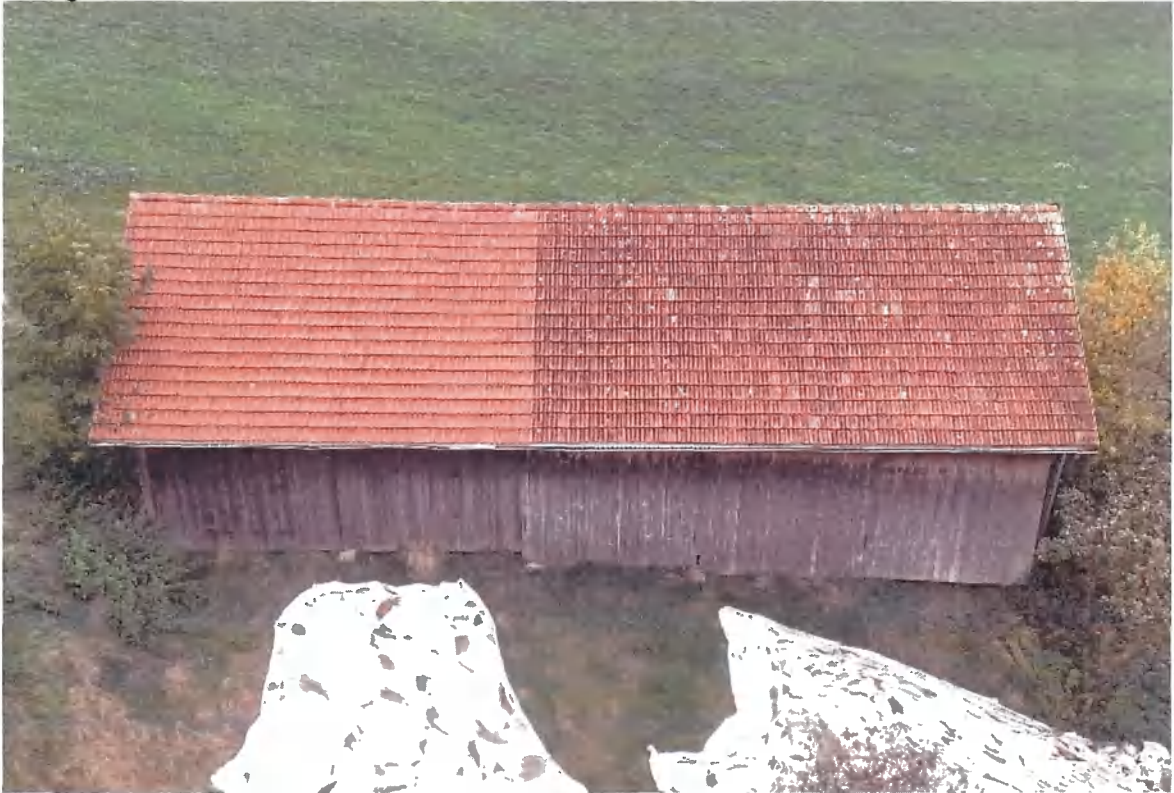
Bild 21: Ansicht der in zwei Bauabschnitten erstellten Maschinenhalle von Westen, Blickrichtung Osten (Gebäude 5). Die Maschinenhalle befindet sich bereits auf dem Flurstück 2428. Der im rechten Bildteil zu sehende Südteil ist ca. Bj. 1970 erstellt worden und etwa 1985 ist die Maschinenhalle in Richtung Norden (linker Bildteil) erweitert worden. An der Westseite befinden sich insgesamt fünf Holz-Schiebetore, über die man nur von der Hofstelle aus und damit nur über das Flurstück 2427 in die Maschinenhalle einfahren kann.
