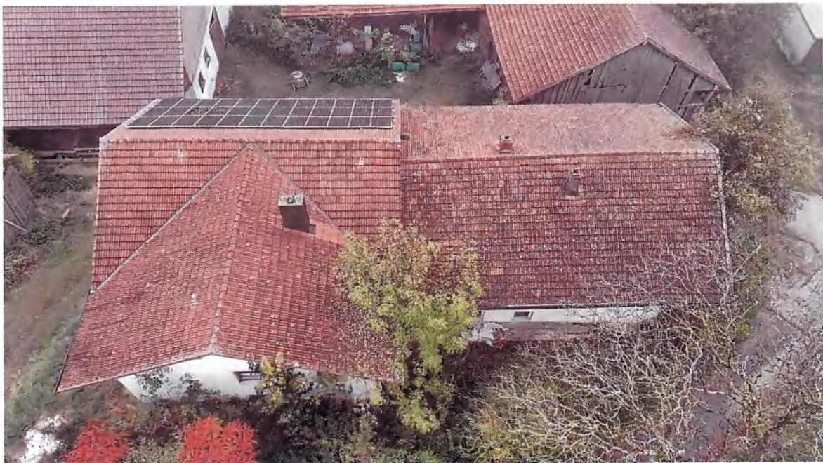
Bild 8: Ansicht des in zwei Bauabschnitten erstellten Wohnhauses von Norden, Blickrichtung Süden. Im linken Bildteil der im Jahr 1989 erbaute Ostteil (Gebäude 1/2) mit der auf der Südseite des Daches montierten Photovoltaikanlage und im rechten Bildteil anschließend der zwischen etwa 1900 und 1920 erbaute Westteil des Gebäudekomplexes (Gebäude 1/1). Dahinter die Nordseite des L-förmigen Scheunenkomplexes (Gebäude 2/1 und 2/2).
