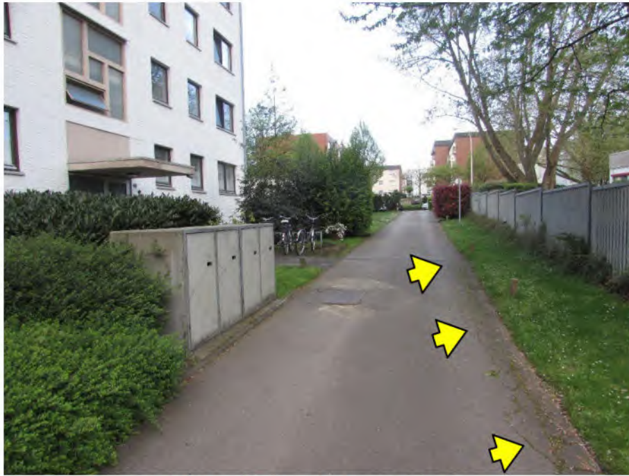
Foto 10: Zugang/Zufahrt: tlw. beschädigte Asphaltierung
