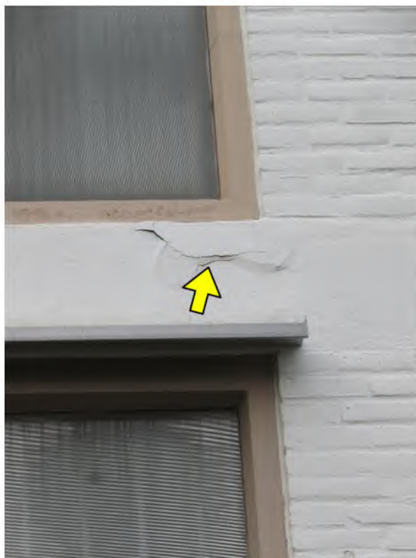
Foto 4: Wohnhaus-Fassade (hier: Haus Nr. 44): Betonabplatzungen
