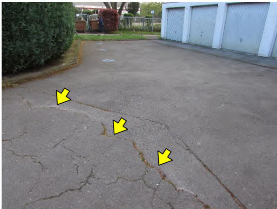
Foto 11: Zufahrt zu den Garagen: gerissene Asphaltierung
