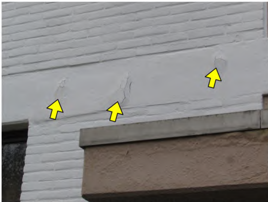
Foto 2: Wohnhaus-Fassade (hier: Haus Nr. 44): Betonabplatzungen
