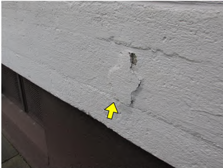
Foto 3: Wohnhaus-Fassade (hier: Haus Nr. 44): Betonabplatzungen
