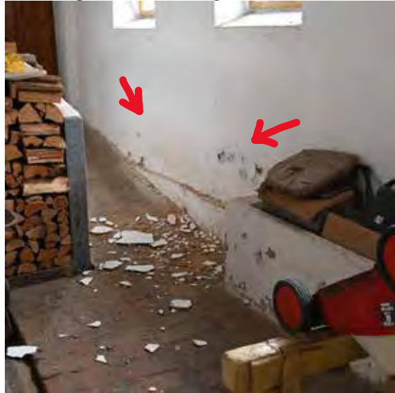
aufsteigende Feuchtigkeit
