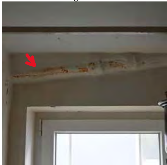
korrodierte Leitungen
