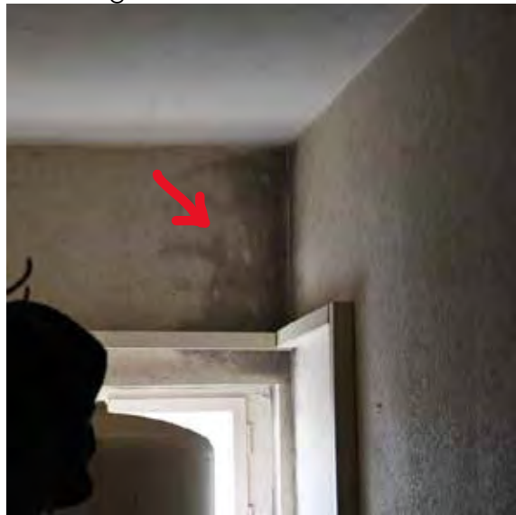
Feuchtigkeit an der Decke
