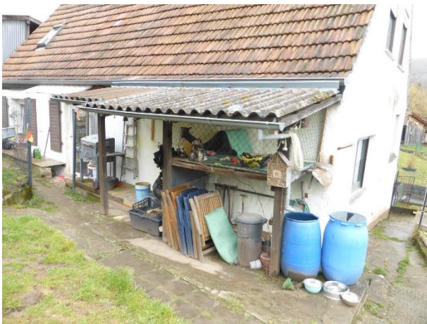
Bild 3: Wohnhaus: rückwärtige Teilansicht
