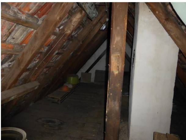
Bild 12: Wohnhaus: DG: Dachboden: Teilansicht
