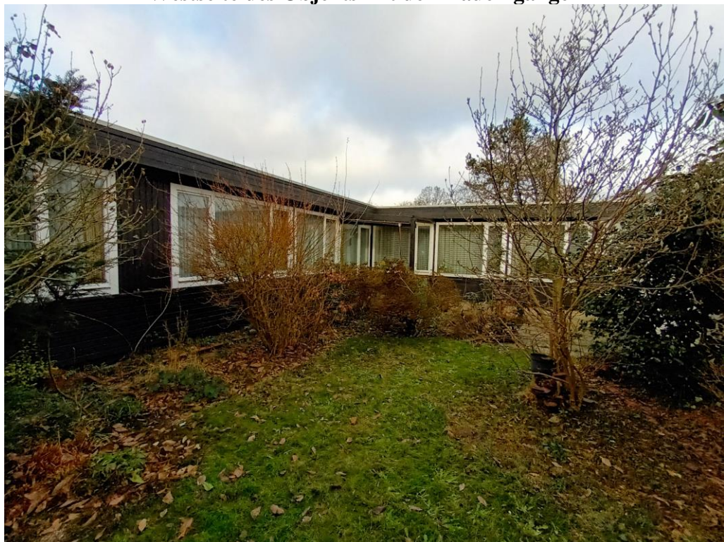
Detailaufnahme Zustand der Ost- und Südfassade mit schadhafte Holzverkleidungen und Fenstern
