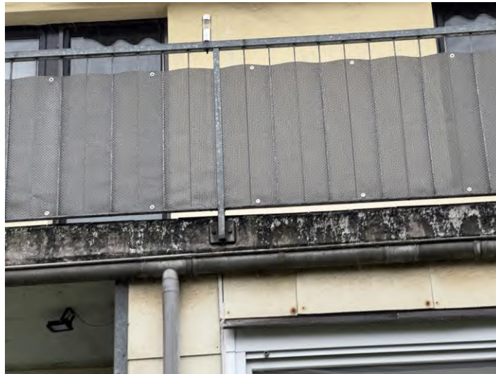
Bild 23: Schadensbild mit Feuchtigkeitsmerkmalen am Balkon
