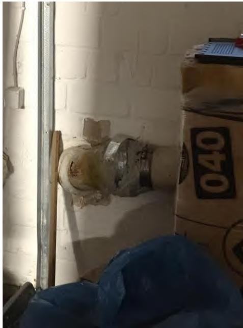
Bild 21: Schadensbild Hauptabflussrohr im Kellergeschoss
