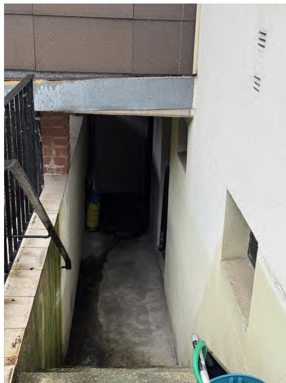
Bild 24: Schadensbild mit Feuchtigkeitsmerkmalen an der Kelleraußentreppe
