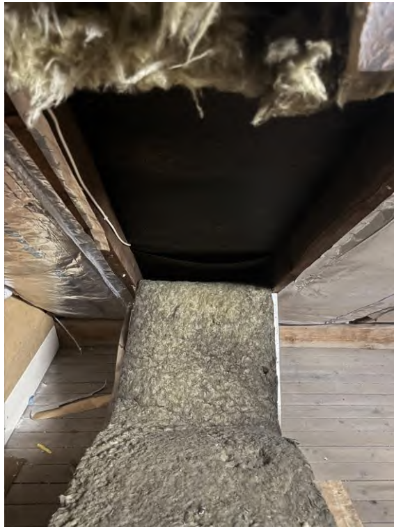
Bild 19: Schadensbild Zwischensparrendämmung
