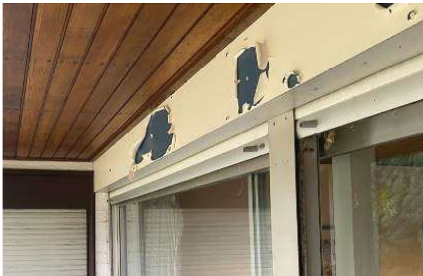
Abb. 1: Foto des SV; z.T. Farbablösungen der Rollladenkästen
