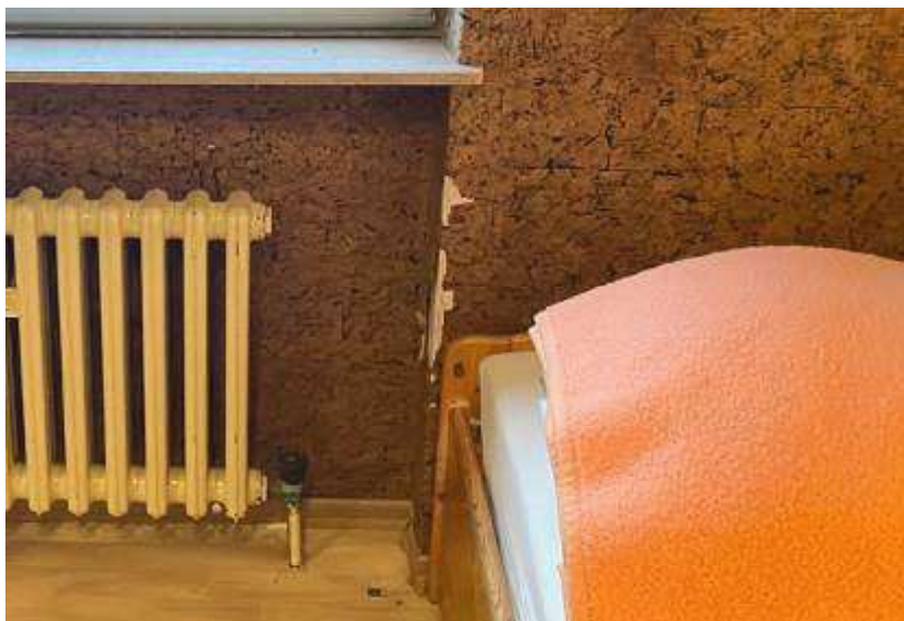
Abb. 3: Foto des SV; z.T. Wandbekleidungen überaltert/schadhaft
