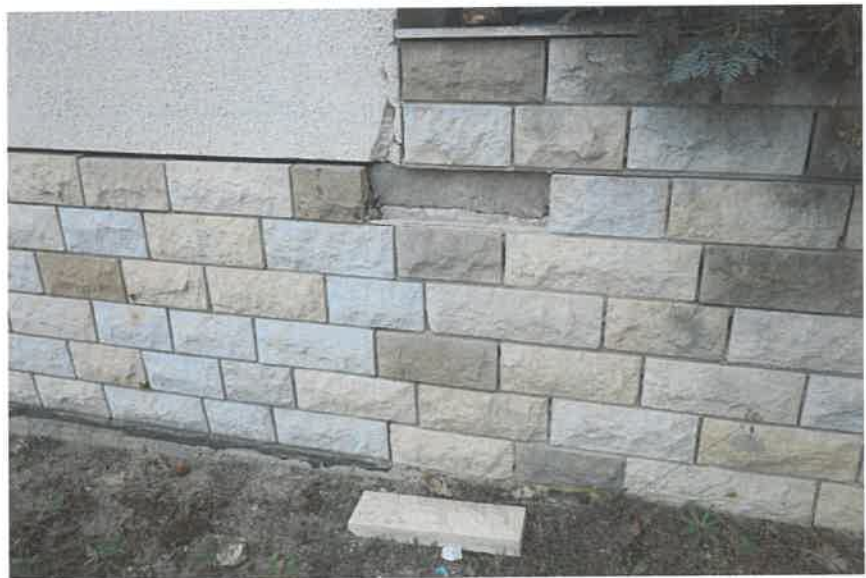
Sichtschäden im Bossenmauerwerk
